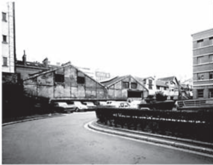
Entrepôts rue Boissonade avant démolition
