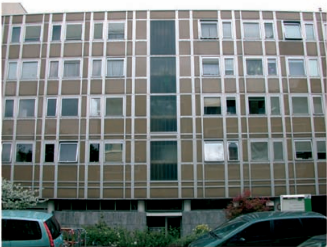
Façade sur cour
