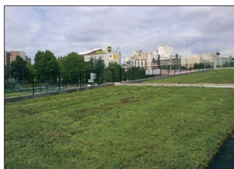
Couverture du périphérique Porte de Vanves
