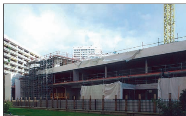
Groupe scolaire Alain Fournier, en construction
