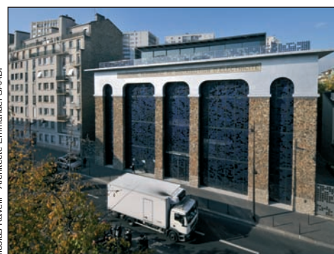
Un ancien local d'EDF reconverti
