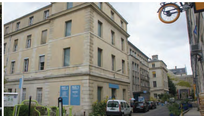
CED remplacé par nouvel îlot « Petit ».
