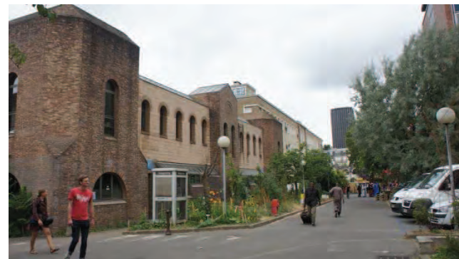
et le bâtiment Colombani : remplacés par le nouvel îlot « Chaufferie »
