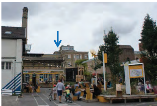
La Chaufferie (en briques) et sa cheminée
