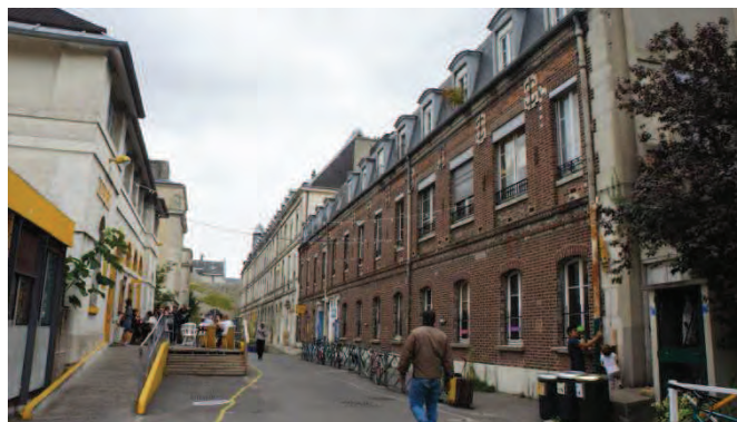
Lingerie (remplacée) Oratoire (pierres blanches) et Robin (briques) conservés
