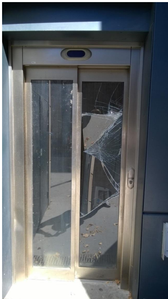
Photographie 1 : Ascenseur du 30, rue du Chevaleret (13°)
