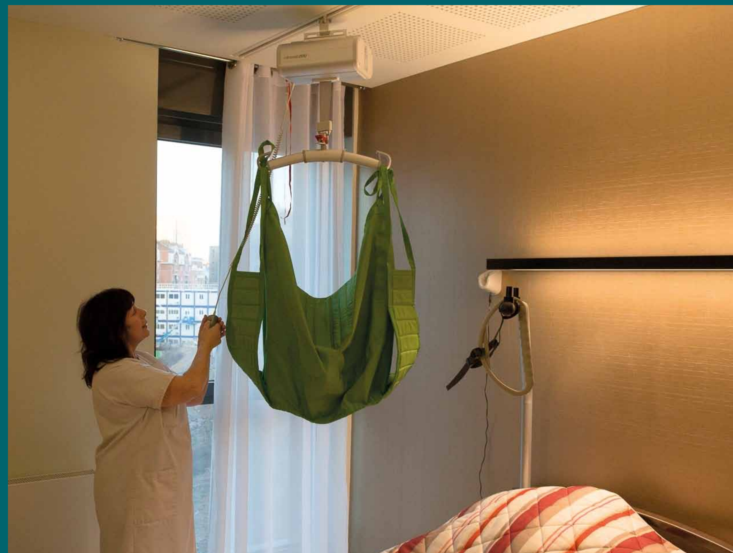
↑ Résidence Annie Girardot (Paris 13 e , 2012) : toutes les chambres sont équipées d'une nouvelle technologie permettant aux soignants de lever et de déplacer les résidents sans effort et en sécurité grâce à un système de rail de transfert.
