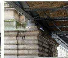
Les piles et piliers en maçonnerie de pierre
