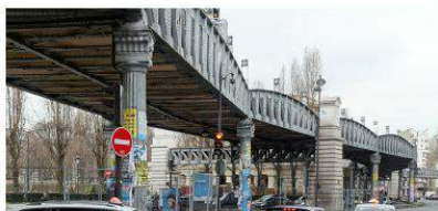
Les arches métalliques externes et internes
