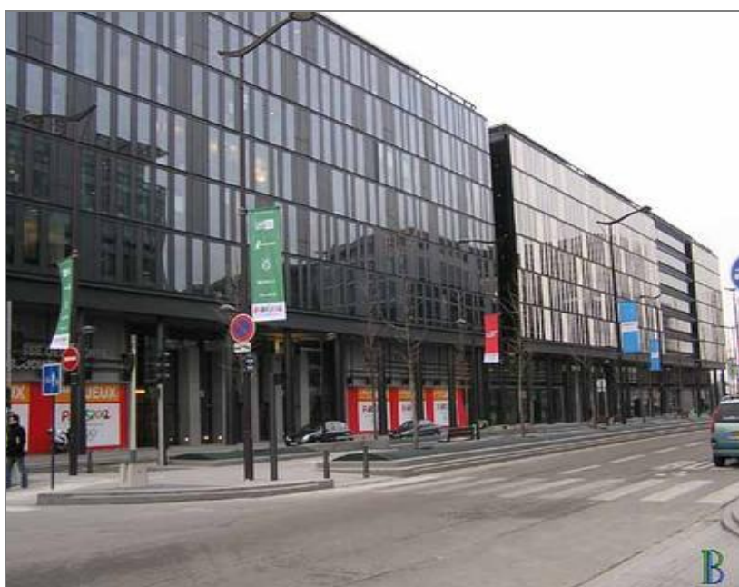
Figure 13 : Photographie de l'immeuble administratif situé 103, avenue de France
