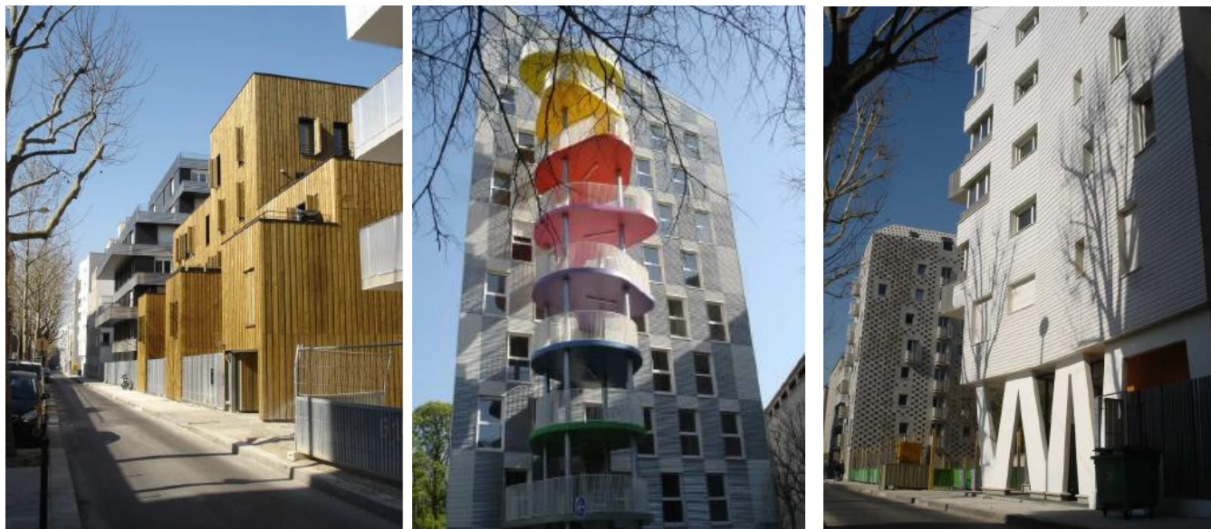
Figure 5 : Exemples d'immeubles de la rue Rebière dans le 17 ème arrondissement
