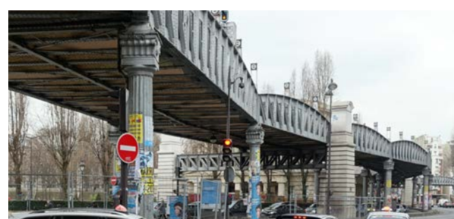
Les arches métalliques externes et internes
