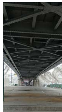
Le tablier en structure métallique à caissons ou voutelettes en brique
