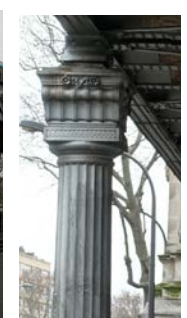
Les piliers et colonnes en fonte
