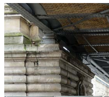
Les piles et piliers en maçonnerie de pierre
