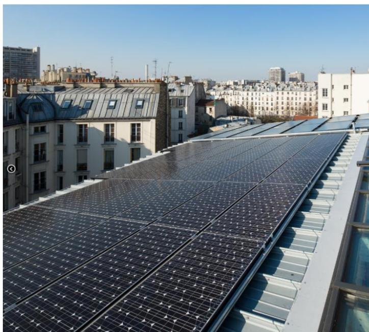
Grâce à 160 m<sup>2</sup> de panneaux photovoltaïques installés sur le toit, à une forte isolation et à des innovations comme la récupération de la chaleur des eaux de douche, l'ensemble de l'immeuble dispose de sources d'énergie propres pour couvrir les différents besoins des locataires. Les persiennes ont été dotées de faces-miroir afin de refléter la lumière du soleil à l'intérieur des 17 logements sociaux.
