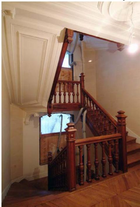
trémie, reprise et doublage des planchers, dépose d'une verrière remplacée « à l'identique ». D'importants remaniements intérieurs ont été effectués dans les appartements des étages de l'immeuble grâce à de simples déclarations de travaux. Nonobstant, l'hôtel conserve son escalier, d'importants vestiges de moulures de plafond de belle qualité et des mosaïques de pavement.
