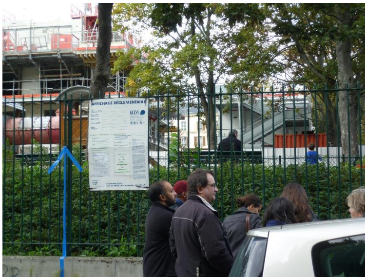
En bleu, limite de l'emprise de la future piscine, le long du square Serpollet.
