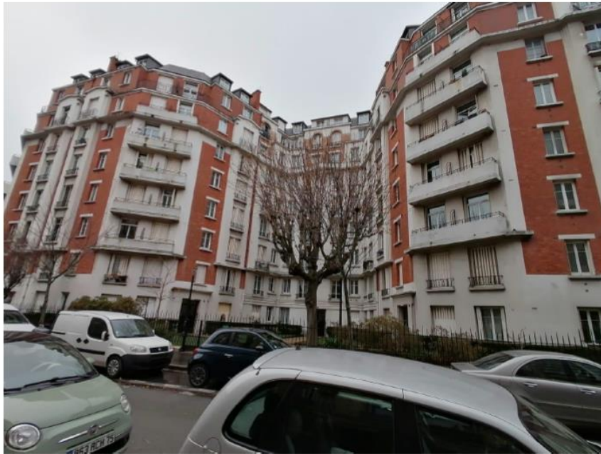
Photo du site vue depuis la rue après travaux
