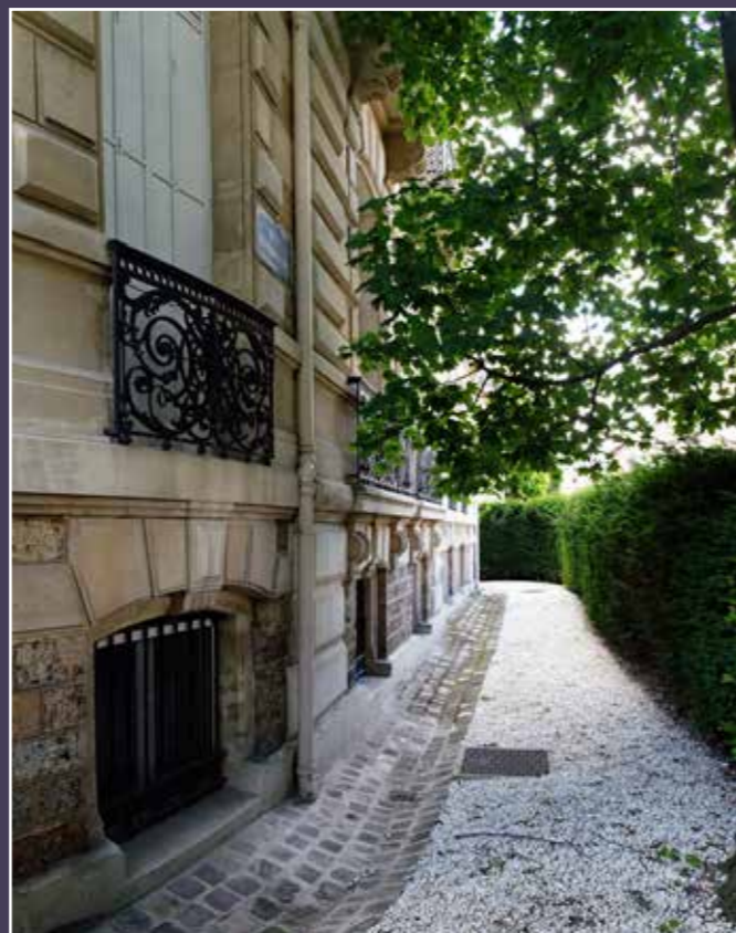
Vue du chemin latéral et des soupiraux.
