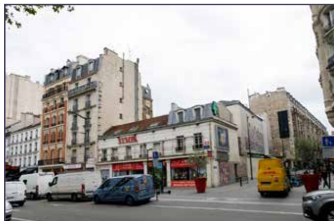
Vue actuelle depuis l'avenue Jean Jaurès.
