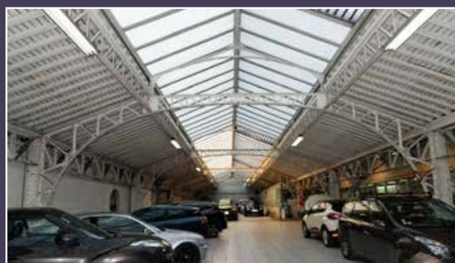
Vue actuelle des halles à démolir.
