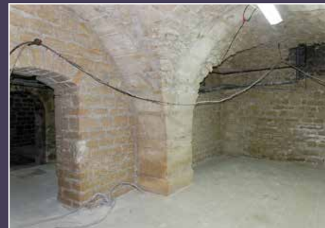
Vue de la cave du corps de logis sur rue.
