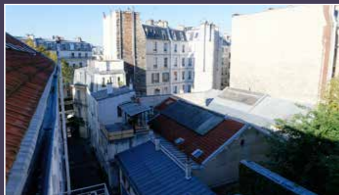
Vue en hauteur de la cour en lanière.
