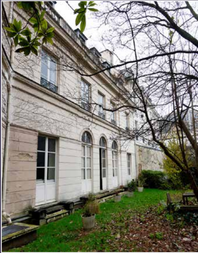
Vue de la façade sur jardin.
