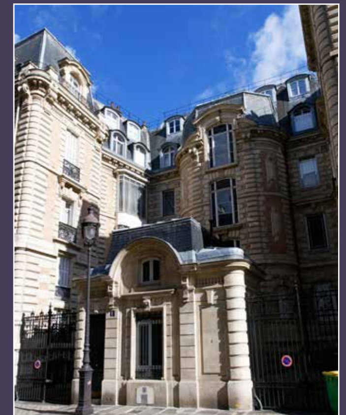
Vue de la cour et de la loge du gardien au 8, rue Murillo.
