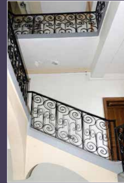
Vue des dernières volées de l'escalier.
