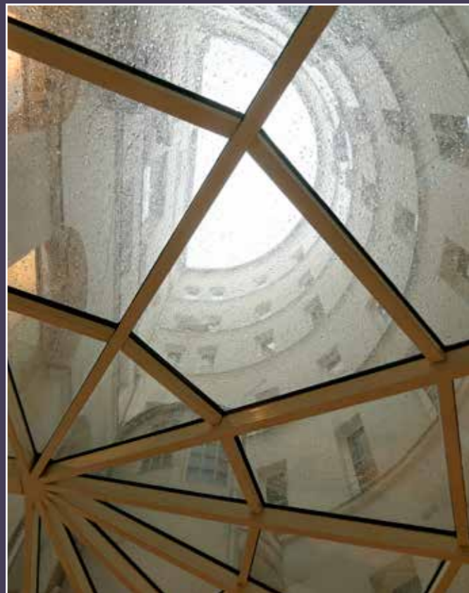
Vue actuelle sous la verrière.
