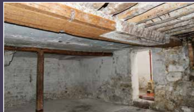
Rez-de-chaussée de la travée gauche du corps de logis sur cour, donnant sur la courette arrière.
