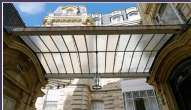
Vue de la verrière moderne.
