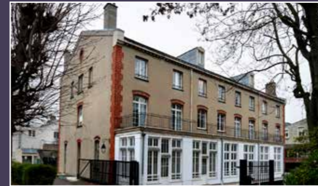
Vue actuelle du bâtiment dit des « Quatre Vents » dû à Eugène Hénard.
