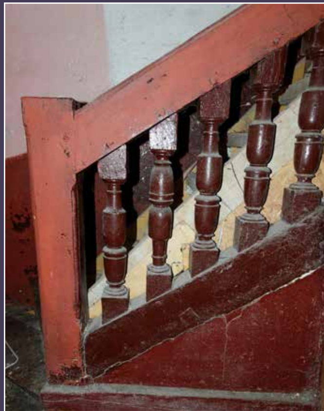
Départ de l'escalier de l'entresol dans le corps de logis sur cour.
