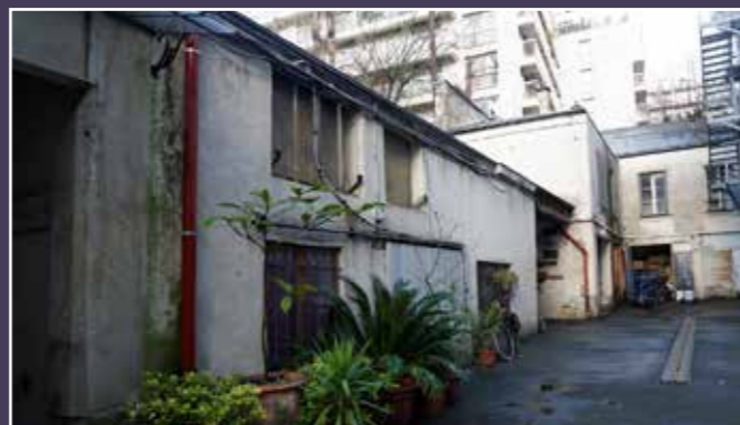
Vue actuelle des ateliers édifiés le long de l'héberge nord dont la démolition est demandée.
