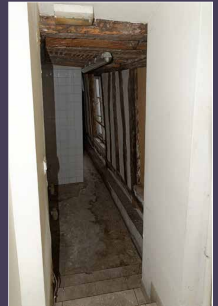
Premier étage de la galerie.
