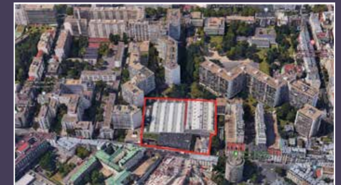
Vue aérienne du site et repérage des bâtiments concernés (© Hardel Le Bihan / Barrault Pressacco / DVVD architectes).
