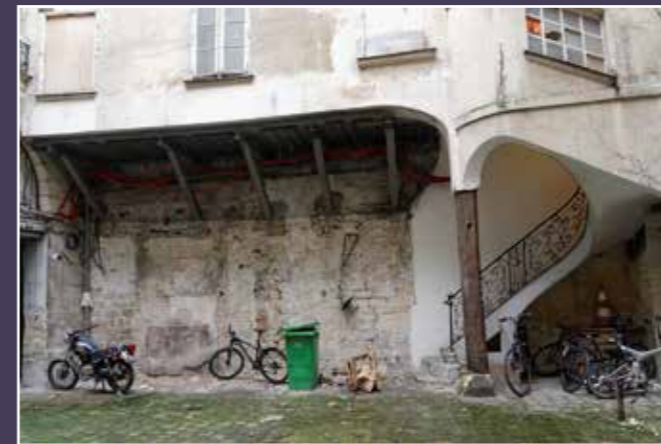
Supports modernes de la galerie et escalier hors œuvre.
