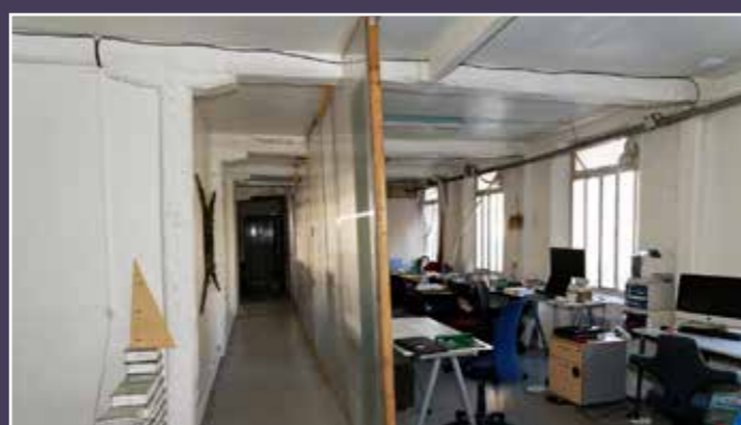
Vue intérieure d'un plateau d'atelier de la grande halle en structure bois dont la rénovation est envisagée.
