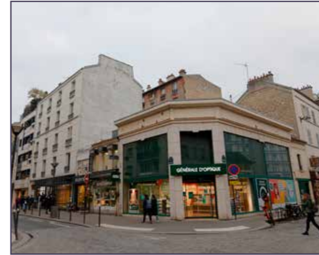
Vue actuelle depuis l'angle des rues du Commerce et Letellier.
