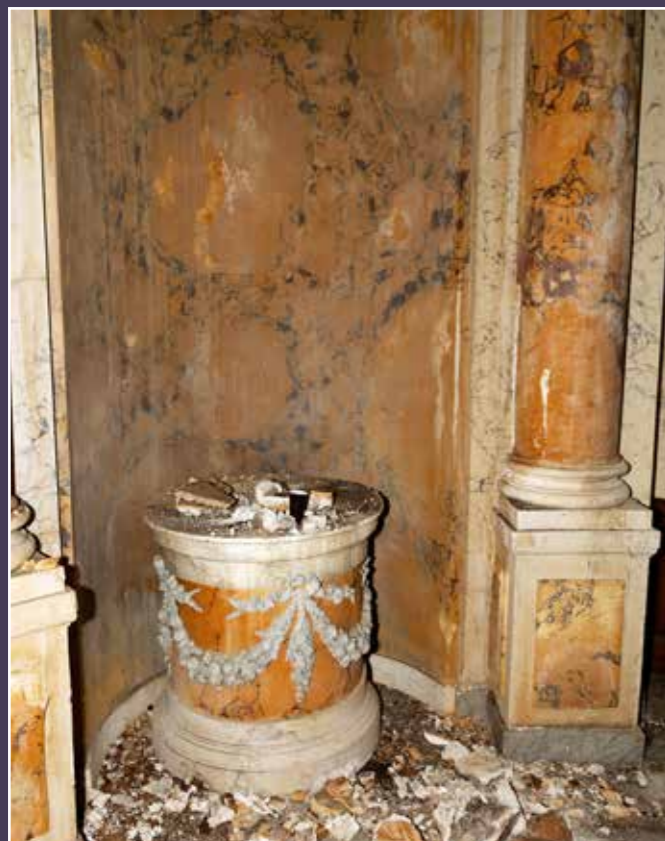
Chute d'éléments de décor en stuc au droit de l'infiltration.
