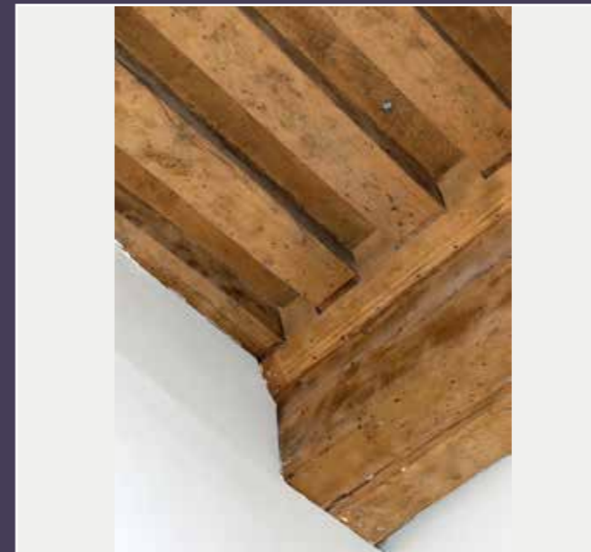
Détail de plafond.
