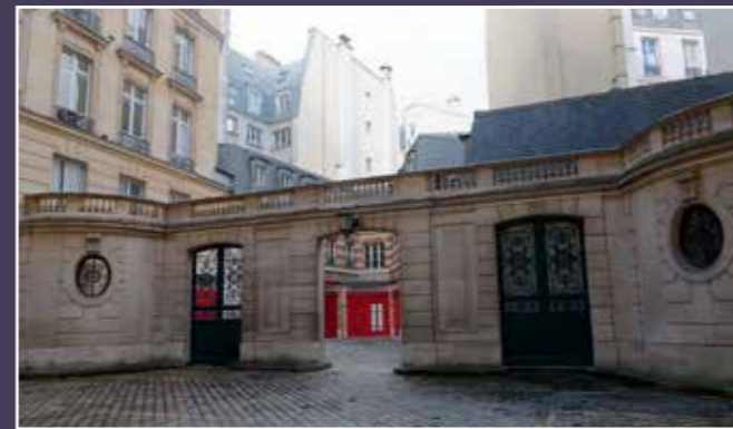
Vue du mur de clôture qui sépare la cour principale de la cour des annexes.
