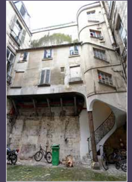
Vue de la galerie sur cour et de l'escalier hors œuvre.
