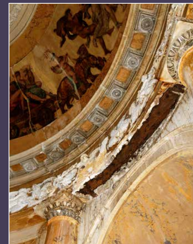
Détail des décors dégradés de l'entablement de la salle à manger au droit de l'infiltration.
