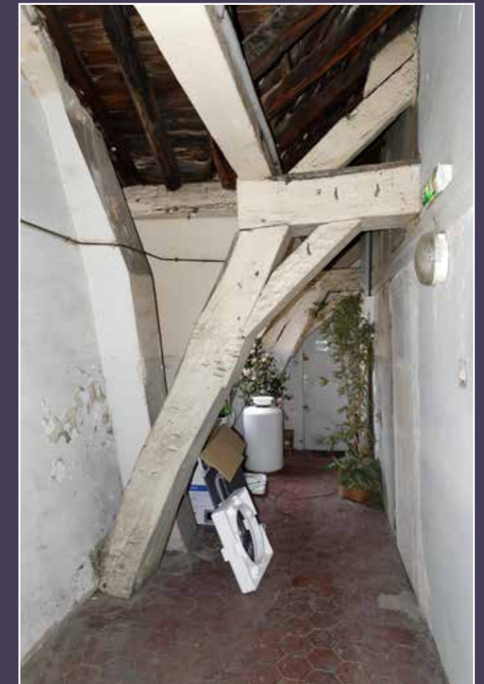
Vue de la charpente du corps de logis sur rue.
