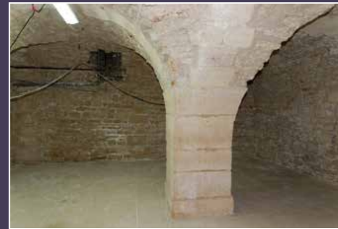
Vue de la cave du corps de logis sur rue.
