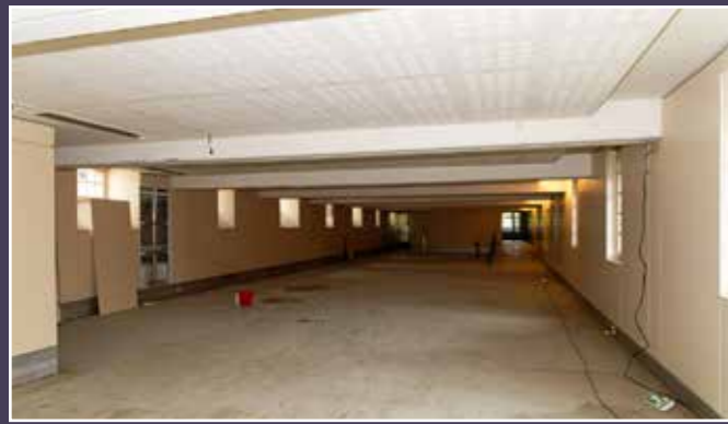
Vue de la sous-terrasse ouest.
