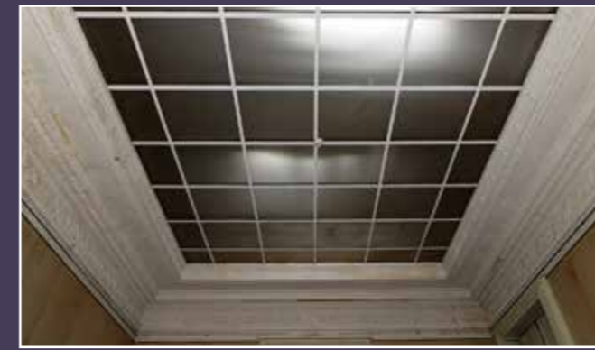
Trianon, vue d'un des faux plafonds.
