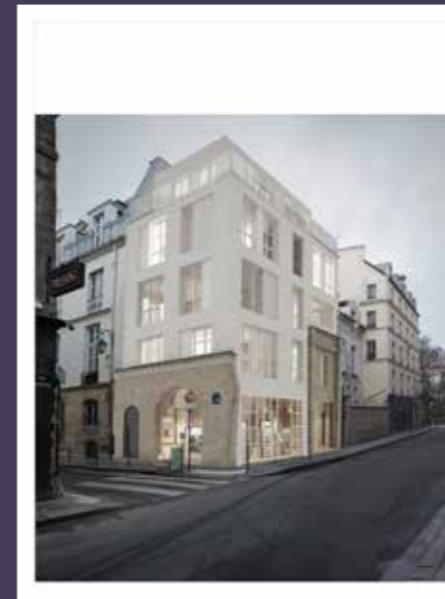
Vue d'insertion à l'angle des rues Portefoin et des Archives (© ABDF architectes).
