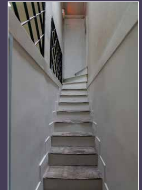
Escalier conduisant au niveau supérieur de la galerie.
