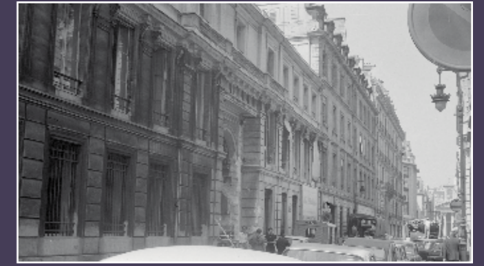
Vue de l'ancien siège de la banque Rothschild sur la rue Laffitte, août 1967 (Casier archéologique).
