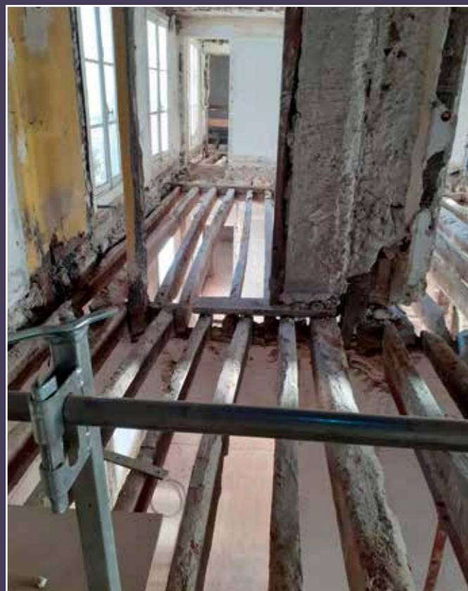
Vue des planchers prise au moment du curage.
