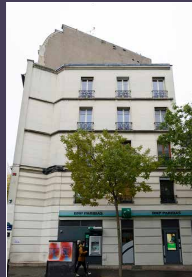
Vue de l'épaississement de l'immeuble sur la rue de Tolbiac.
