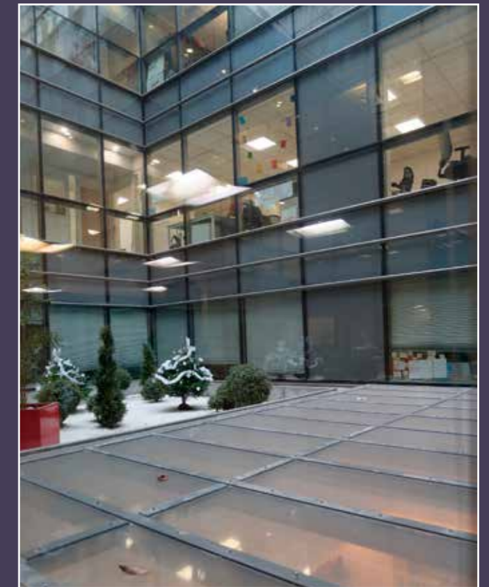
Vue actuelle d'un des patios approfondis en 1997 et des façades recrées.
