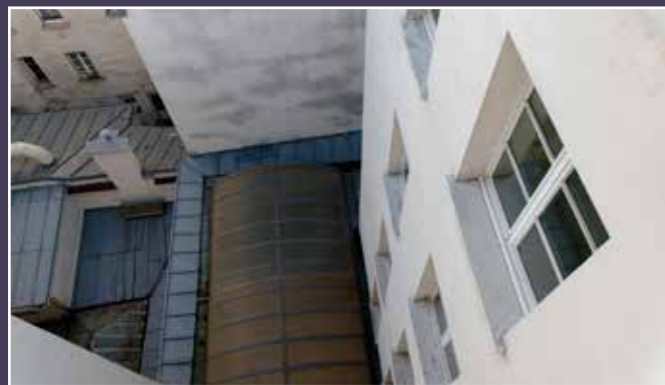
Vue actuelle de la verrière couvrant la cour.
