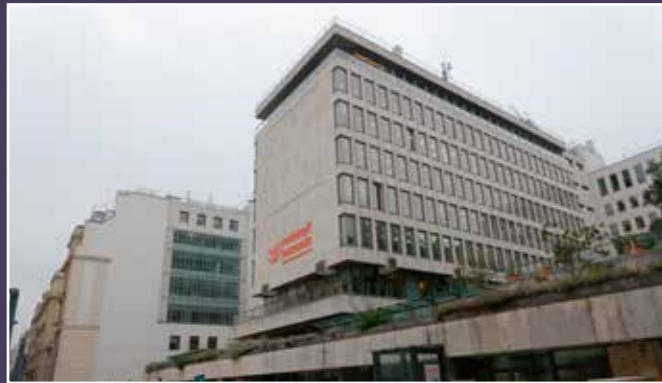
Vue actuelle depuis la rue Laffitte en direction du pignon sud.
