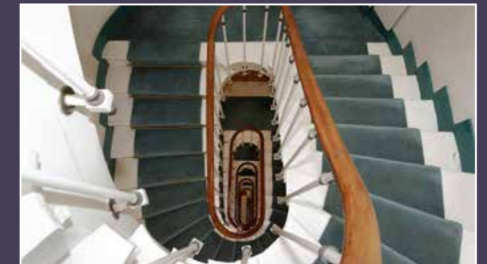
Vue en 2016 de l'escalier qui dessert l'aile au sud de la cour.
