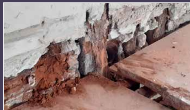
Vue actuelle de l'état des pans de bois.
