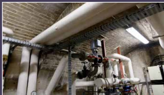
Vues actuelles des caves au rez-de-chaussée abritant des locaux techniques.
