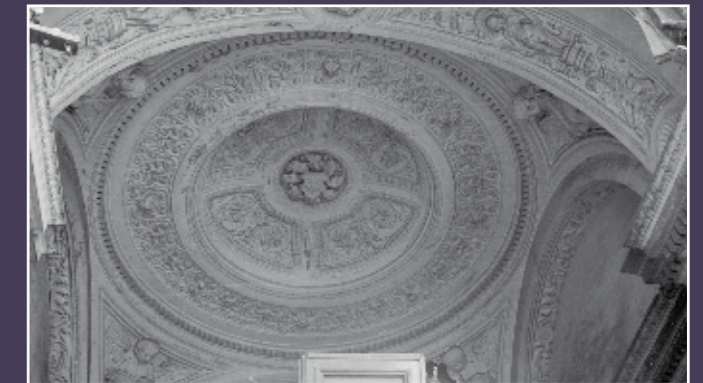
Vue d'un détail de voûte pendant les démolitions, août 1967 (Casier archéologique).
