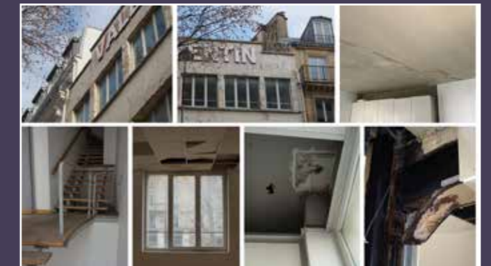
Vues de l'état actuel (© A. Beckmann architectes).
