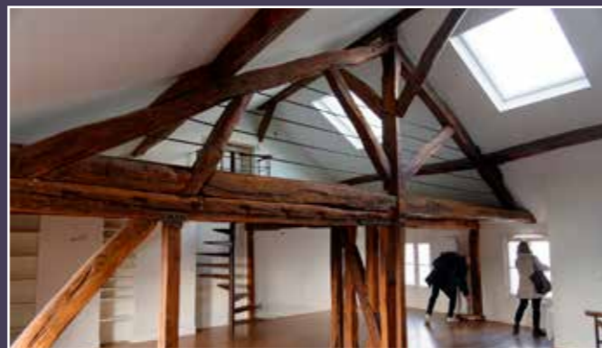
Vue actuelle de la charpente.
