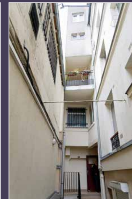
Vue depuis la cour vers l'immeuble d'origine.
