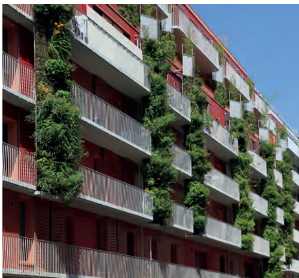
Façade végétalisée (15°) © Jacques Leroy / Ville de Paris
