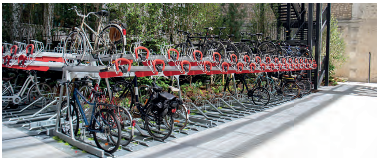
Parking vélos, site réhabilité de Morland (4 e ) © Christophe Jacquet / Ville de Paris
