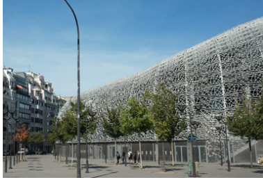
LE STADE JEAN BOUIN (16 e ) rénové en 2012 par l'architecte Rudy Ricciotti à l'aide d'un procédé unique de béton fibré
