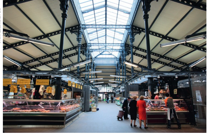
LE MARCHÉ COUVERT LA CHAPELLE RUE DE L'OLIVE (18 e ) dont le bâtiment a été édifié en 1888 dans son style Baltard actuel
