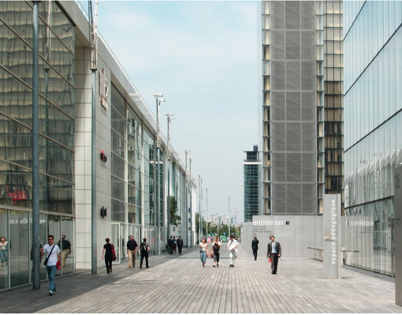
LE PARVIS DE LA BIBLIOTHÈQUE NATIONALE DE FRANCE (13 e ) dessinée par Dominique Perrault et du cinéma conçu par Jean-Michel Willmotte, achevés en 1995 dans le cadre des aménagements de la ZAC Paris Rive Gauche
