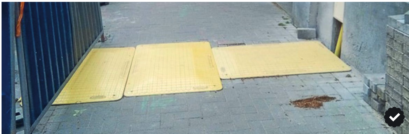
PLATELAGE ANTIDÉRAPANT POUR COUVERTURE DE TRANCHEE
