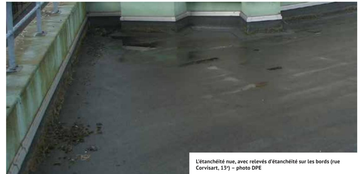
L'étanchéité nue, avec relevés d'étanchéité sur les bords (rue Corvisart, 13°) – photo DPE
