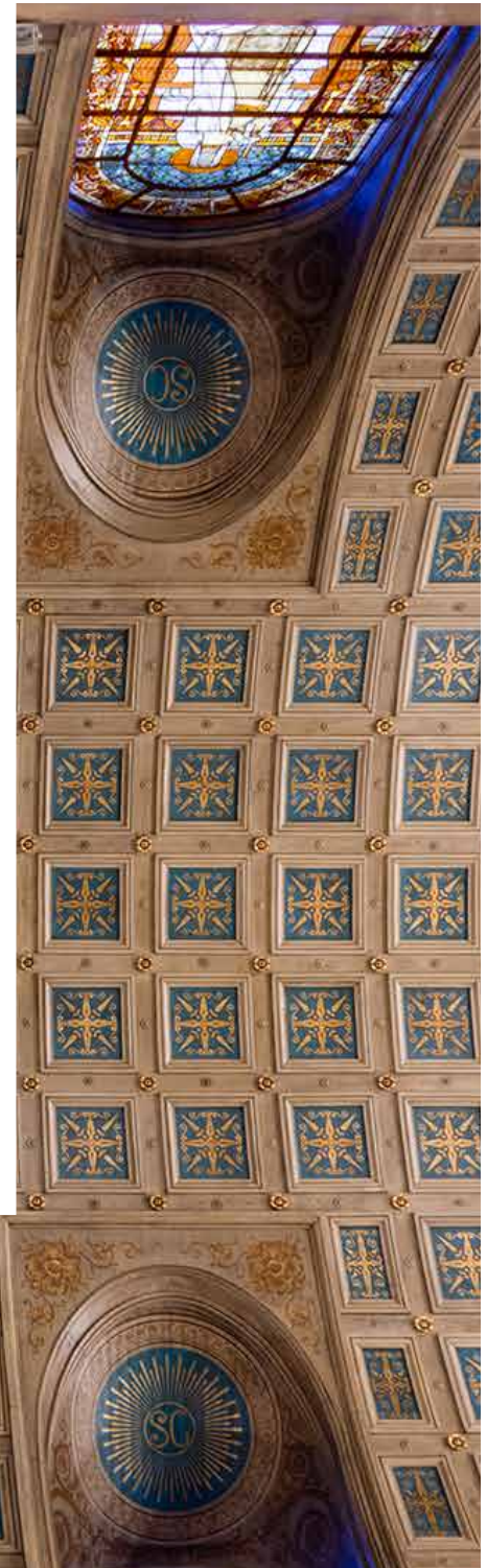
Caissons après nettoyage de la voûte de l'église Saint-Philippe du Roule
