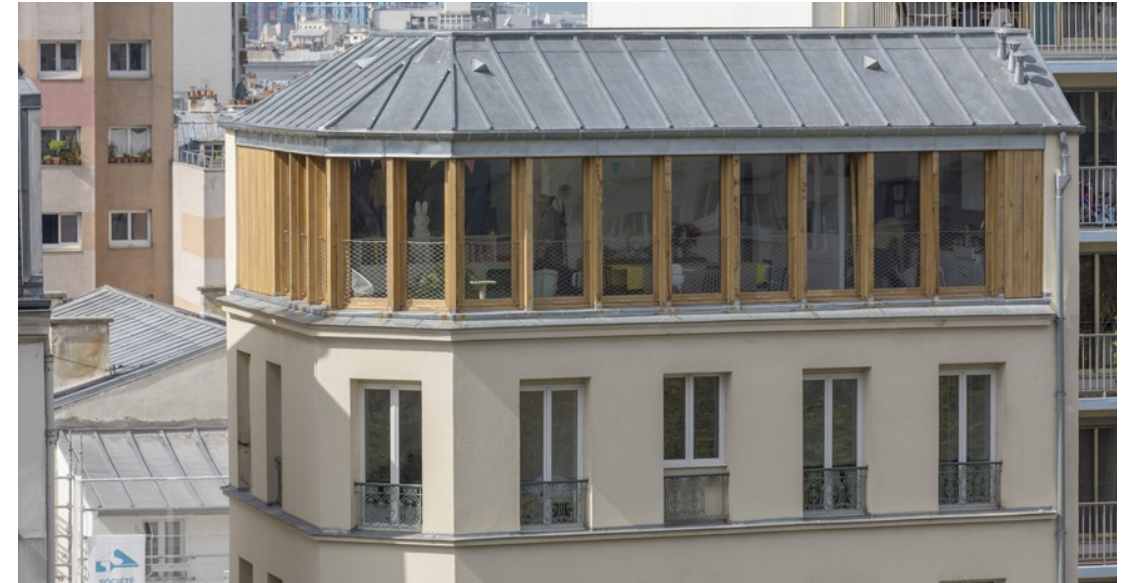
Surélévation, toiture en zinc, NeM, Paris XI
