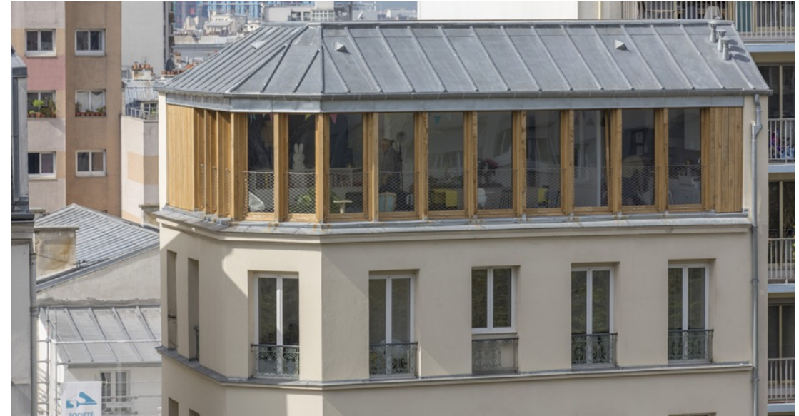
Surélévation, toiture en zinc, NeM, Paris XI
