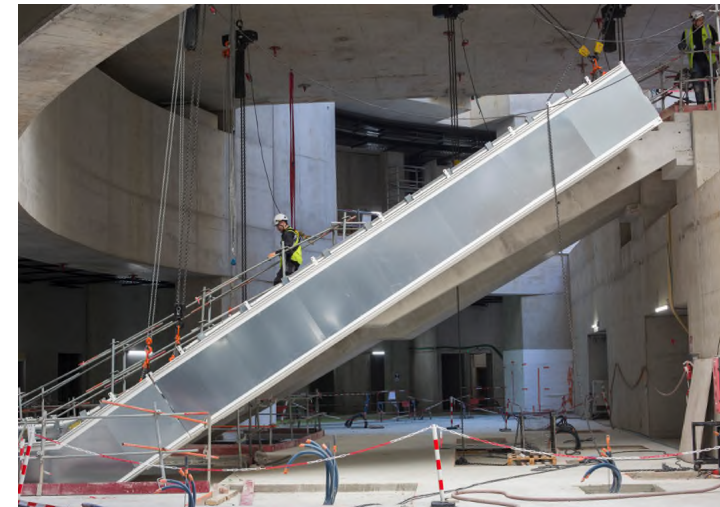
Pose des premiers escaliers mécaniques dans la future gare IGR en mai dernier
