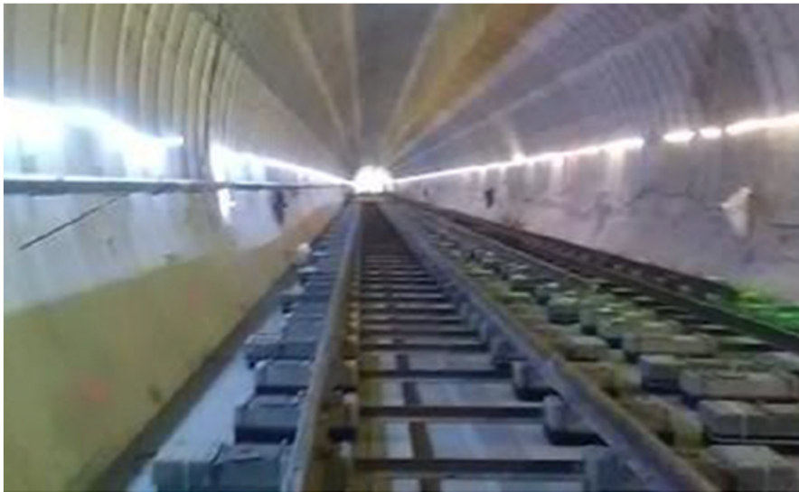
Voies posées en tunnel
