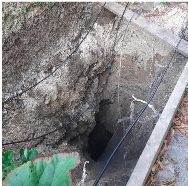
Désordre survenu en 2021 dans la cour du lycée Emile Dubois (Paris 14<sup>e</sup>, site Région Ile-de-France); l'effondrement du terrain est lié au tassement des remblais d'un ancien puits à eau traversant 2 étages de carrières, pour rejoindre la nappe d'eau souterraine. Le tassement progressif du remblais a provoqué la création d'un vide en tête de l'ancien puits, qui s'est ensuite effondré brutalement.
