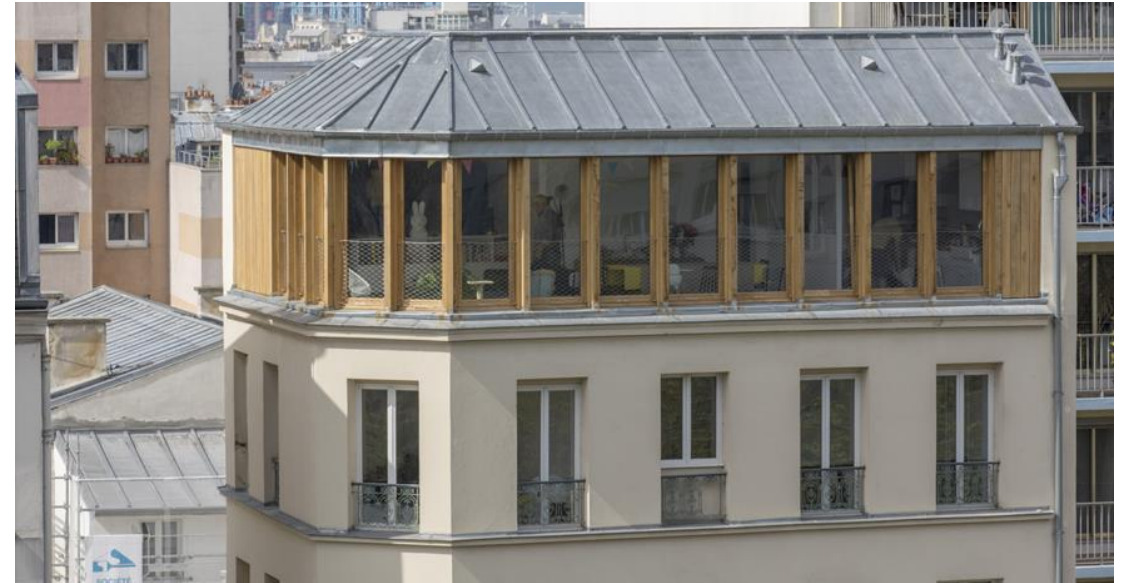
Surélévation, toiture en zinc, NeM, Paris XI
