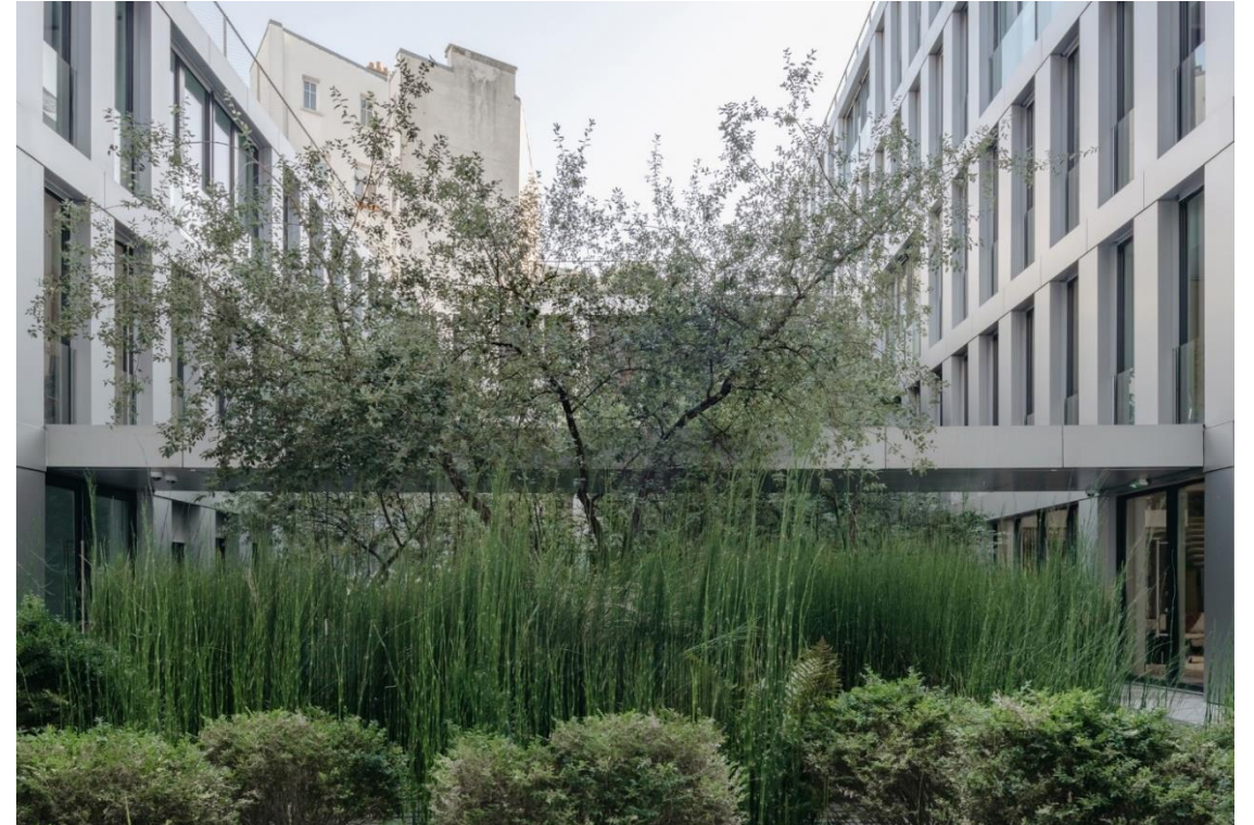
Restructuration et extension, implantation en adossement autour d'un cœur d'îlot végétalisé, Hardel le Bihan, GCI, Paris XVII
