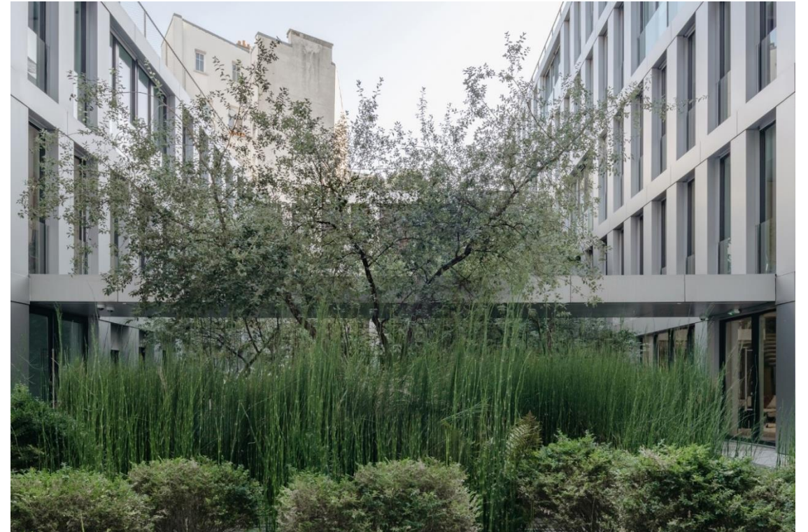
Restructuration et extension, implantation en adossement autour d'un cœur d'îlot végétalisé, Hardel le Bihan, GCI, Paris XVII
