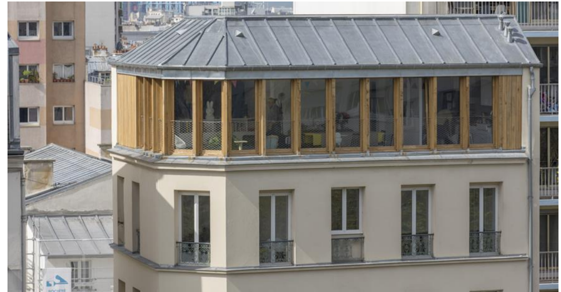
Surélévation, toiture en zinc, NeM, Paris XI
