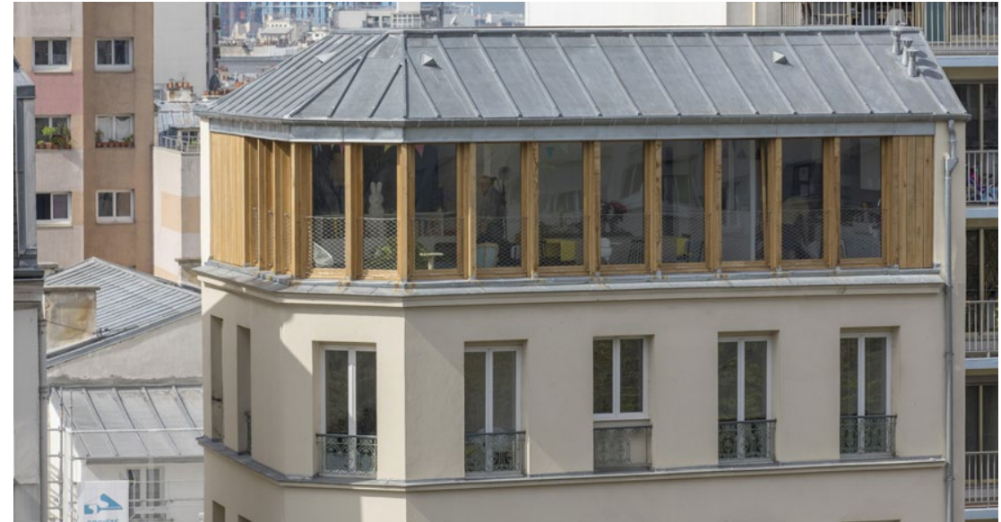
Surélévation, toiture en zinc, NeM, Paris XI
