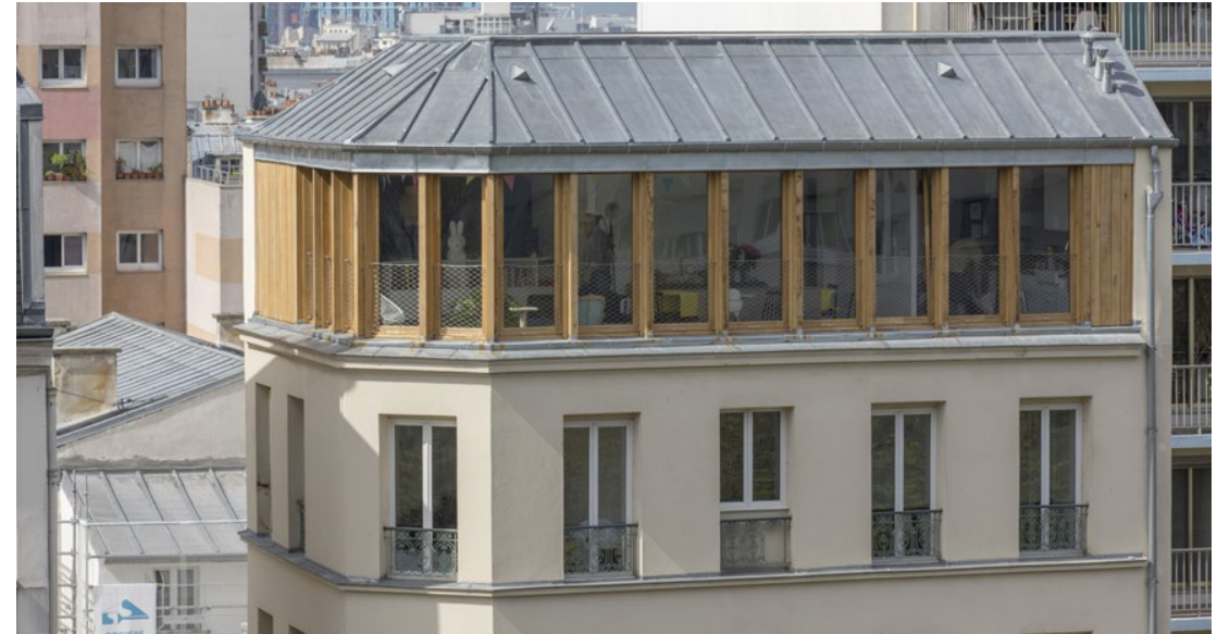
Surélévation, toiture en zinc, NeM, Paris XI
