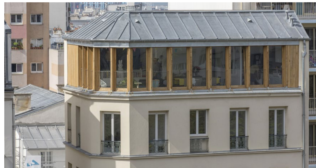
Surélévation, toiture en zinc, NeM, Paris XI
