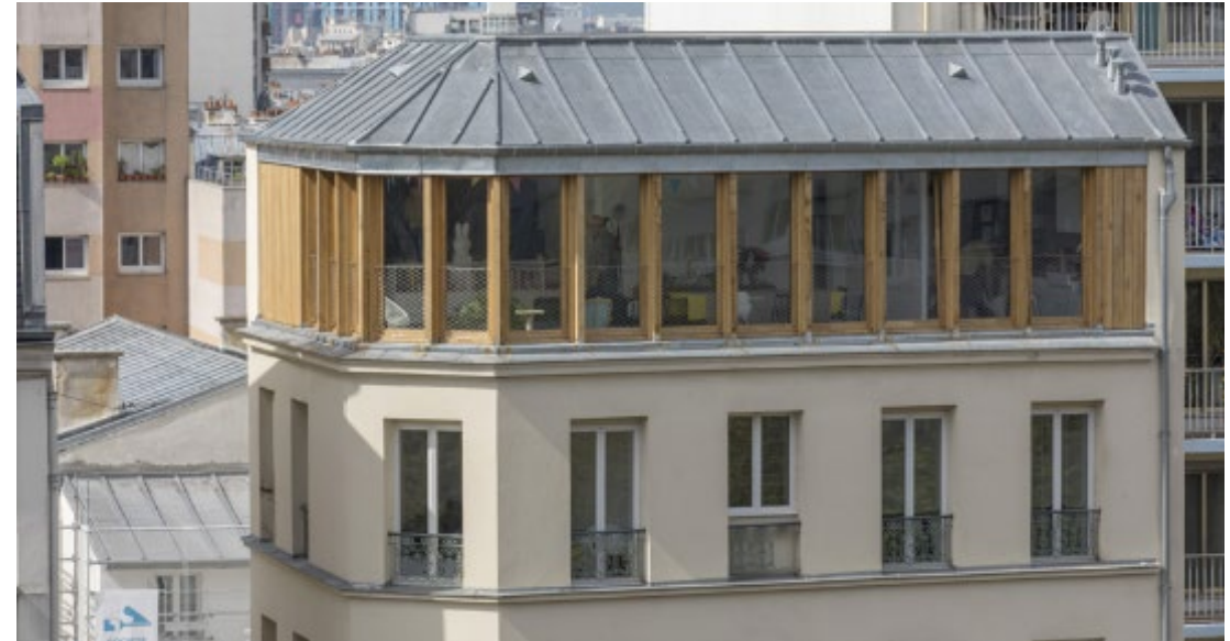
Surélévation, toiture en zinc, NeM, Paris XI
