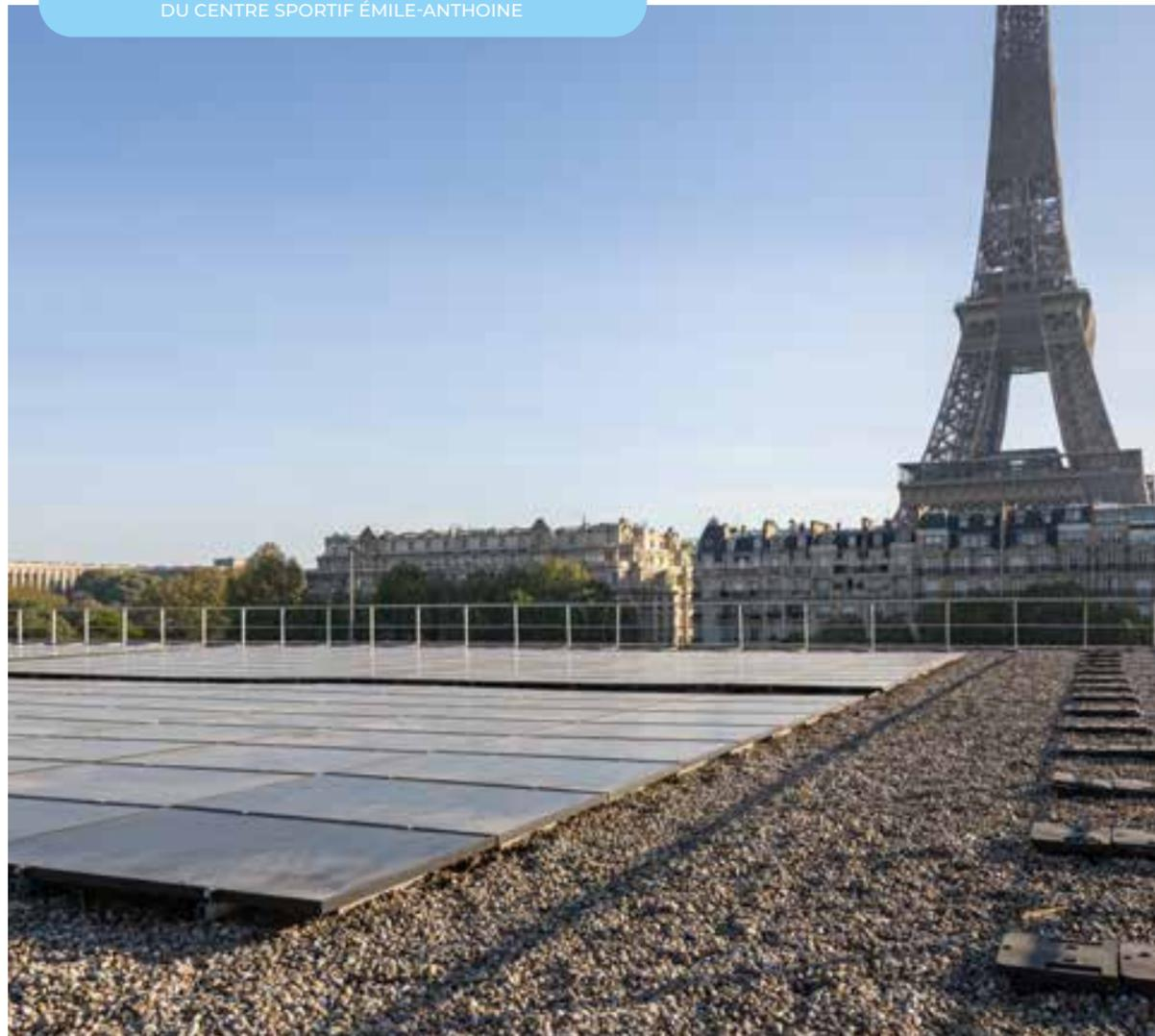
Le 27 avril 2021, 320 panneaux solaires installés sur le toit du centre sportif Émile-Anthoine (15<sup>e</sup>), en face de la tour Eiffel, ont été inaugurés. L'installation photovoltaïque couvre 600 m<sup>2</sup> de toiture pour une puissance électrique total de 100 kWc et une capacité annuelle de production de 90 000 kilowatts-heure (kWh). Mise en service le 20 avril 2021, elle permet d'alimenter l'équivalent de 40 foyers en électricité renouvelable.
