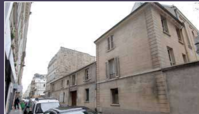
Vue sur la rue de l'Annonciation et reste du bâtiment du n°2 (en 2009 - Cl. C. Rapa / DHAAP).
