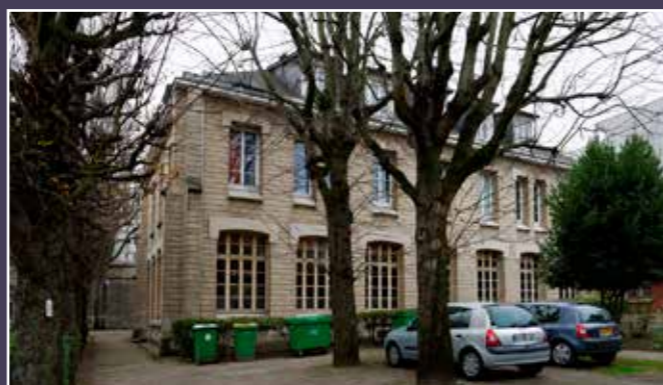
Vue actuelle du bâtiment conventuel.
