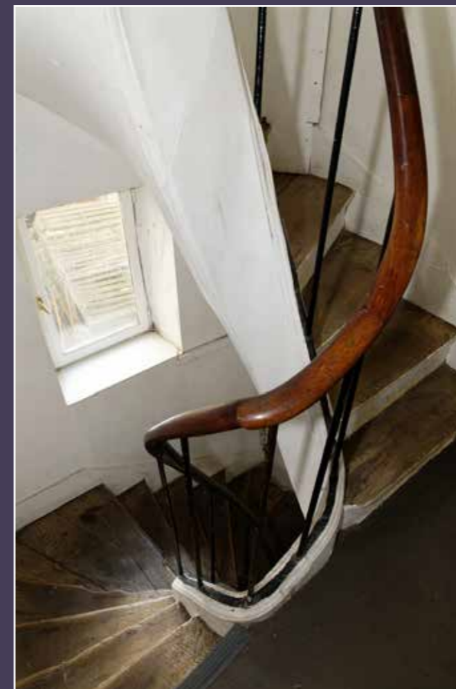
Vue de l'escalier.
