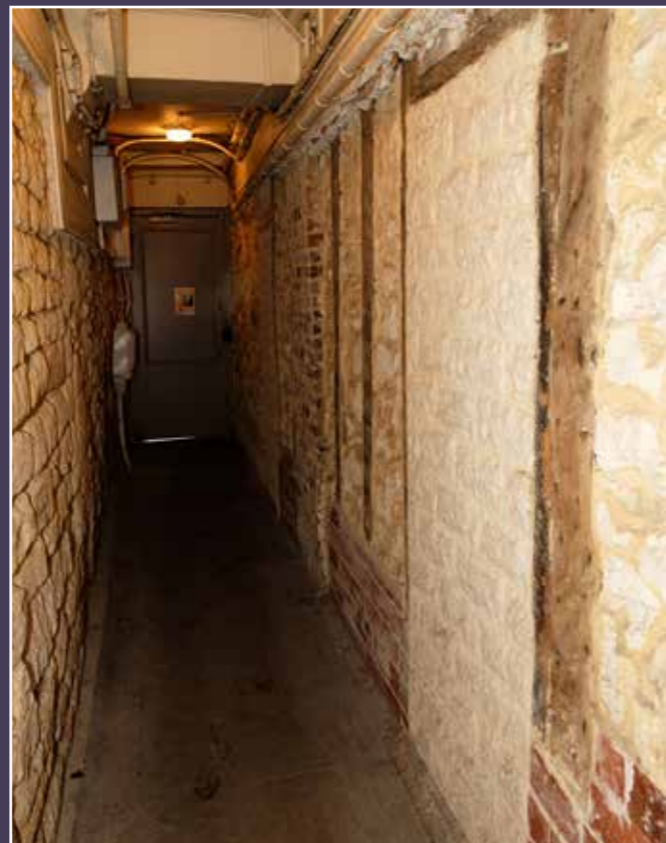
Vue de l'allée de passage située au rez-de-chaussée.
