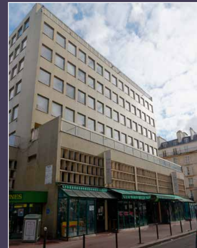
Vue de la façade sur la rue Lebon.
