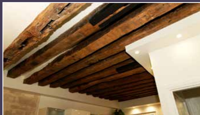
Vue actuelle des solives du plancher du rez-de-chaussée.
