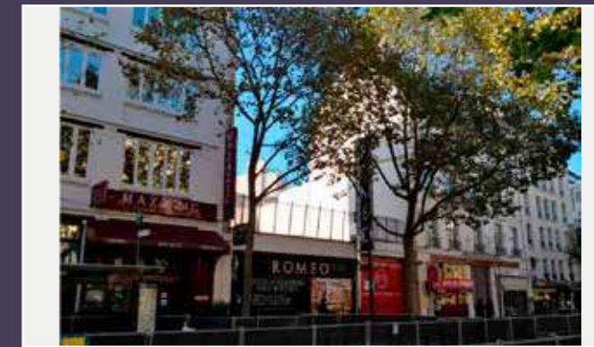
Vue de la façade actuelle sur la rue du Faubourg Saint-Antoine.
