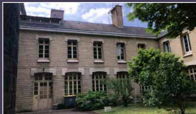
Vue actuelle de l'extension du bâtiment conventuel.
