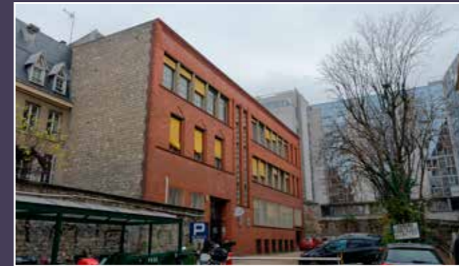
Vue actuelle de la façade principale du bâtiment édifié par Expert.
