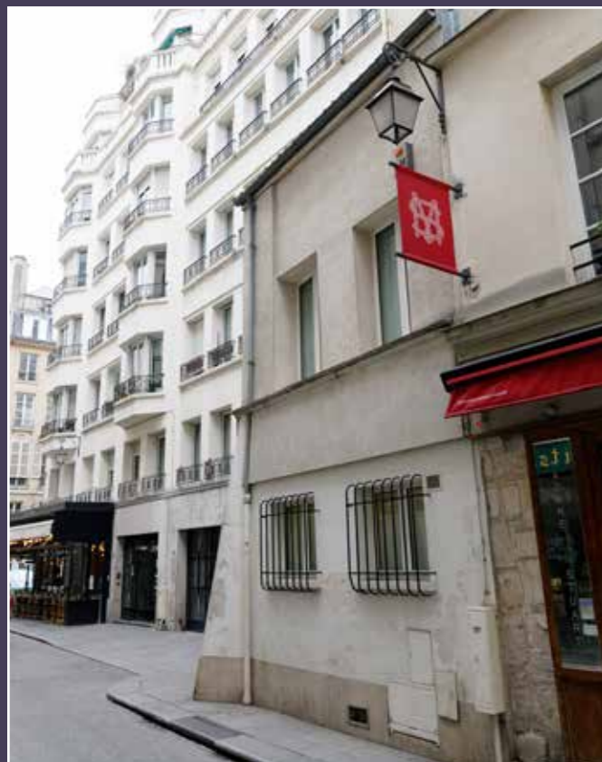
Vue actuelle de la maison, façade sur la rue Marie Stuart.
