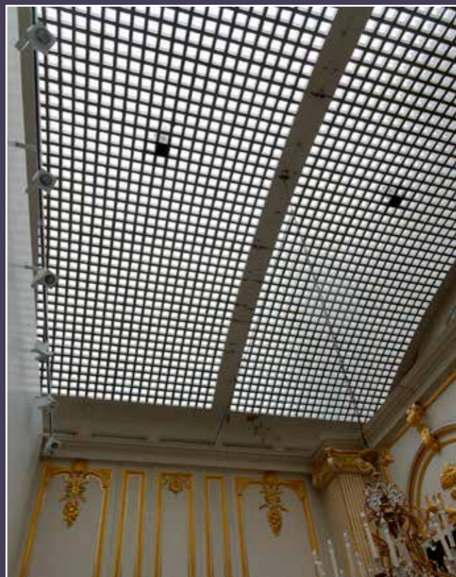
Vue intérieure de la seconde halle voûtée non protégée.
