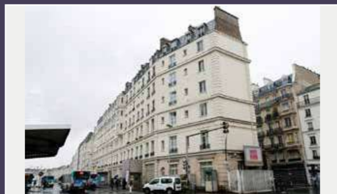
Vue actuelle de l'arrière du bâtiment, donnant sur la gare routière.
