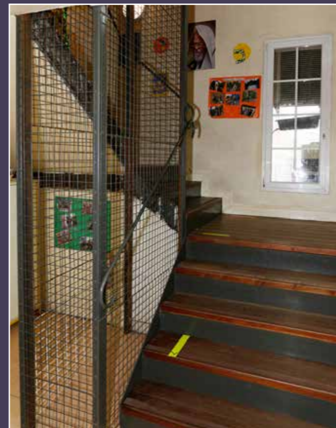
Vue de la cage d'escalier créée illégalement dans les années 1990 et qui sera rebouchée.
