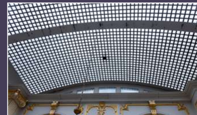
Vue intérieure de la seconde halle voûtée non protégée.
