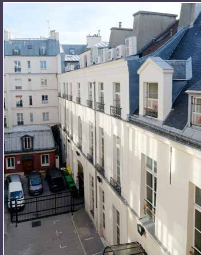
Vue du revers des bâtiments sur rue.
