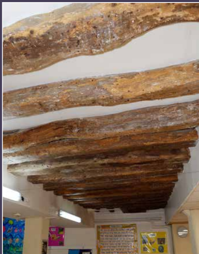
Vue des solives du XVII e dans l'ancien hôtel de Lorraine.
