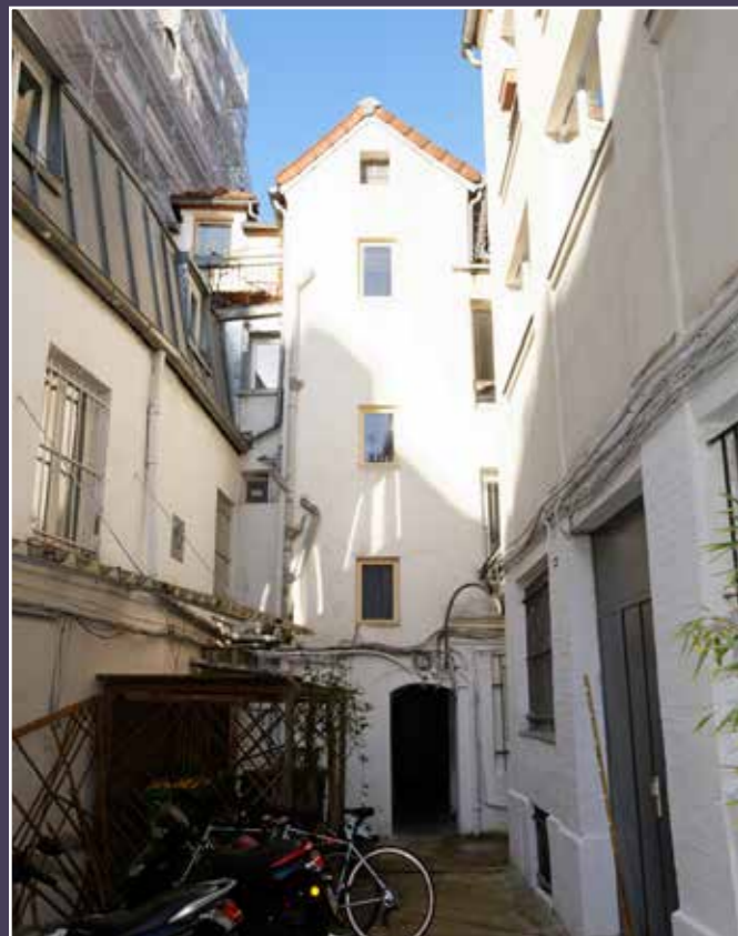
Vue du revers du bâtiment et de sa cage d'escalier en avant-corps.
