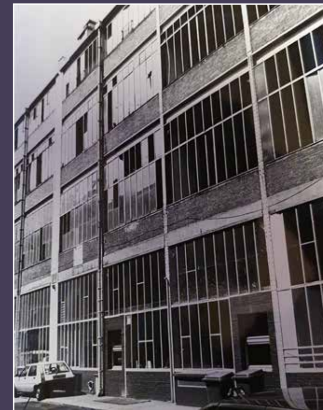
Vue de ce même bâtiment prise par la CVP en 1993.
