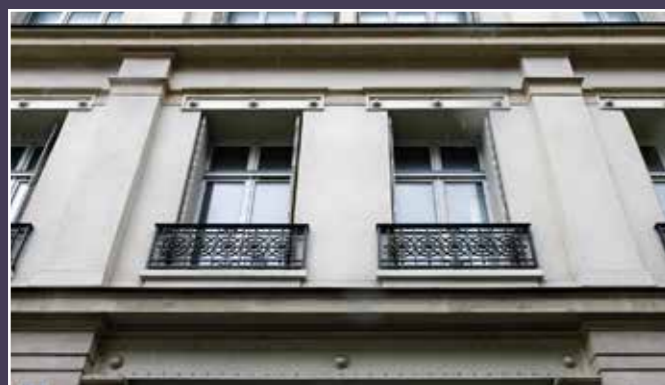
Détail de la façade au premier étage du bâtiment.
