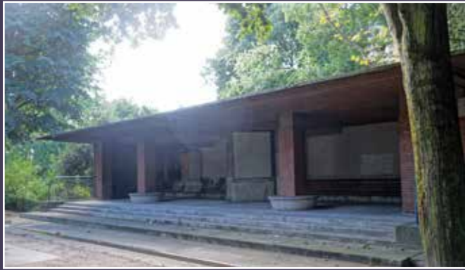
Vue avant de l'abri du Belvédère.
