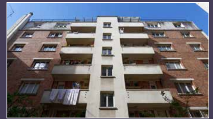
Vue actuelle de la façade du bâtiment sur cour.
