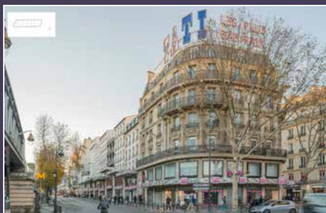
Vue actuelle de l'ilot, façades donnant sur le boulevard Marguerite de Rochechouart et le boulevard Barbes (© Studio Belem).
