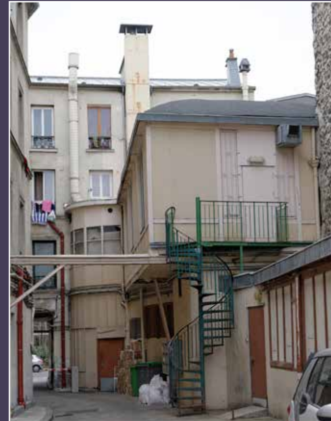
Vue du revers du bâtiment sur rue et de la petite aile sur cour (2014).
