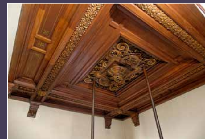
Vue actuelle du plafond en bois de la cage de l'escalier principal.
