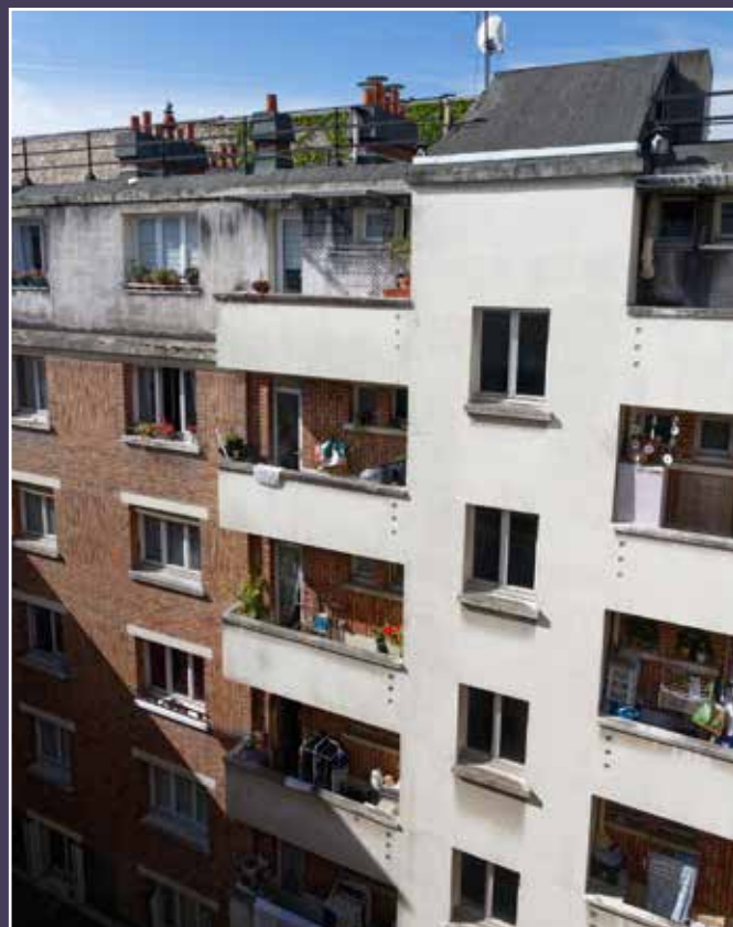
Vue de la façade du bâtiment sur cour.
