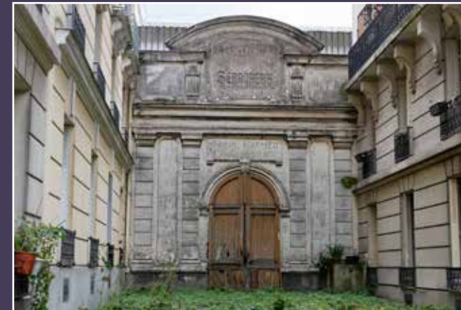
Vue actuelle des vestiges du portail de la Serrurerie, au bout de la servitude de passage au 121, boulevard Ney.
