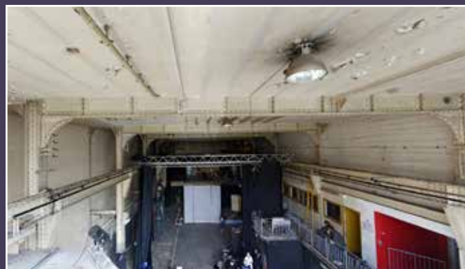
Vue du volume de la nef.
