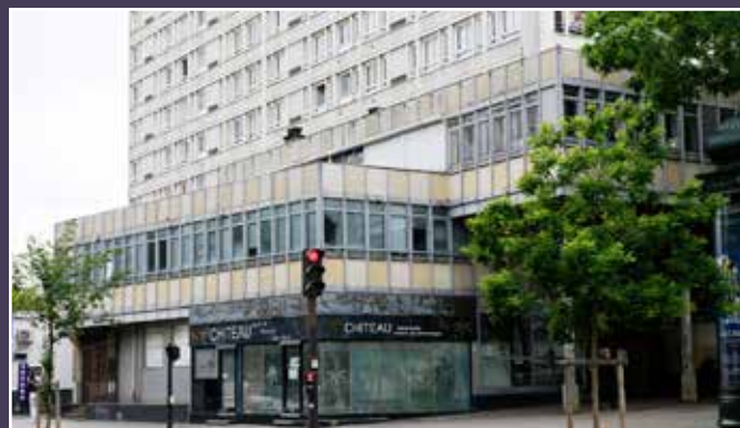
Vue actuelle du socle du peigne sud, des ateliers et bureaux dont la rénovation est demandée.
