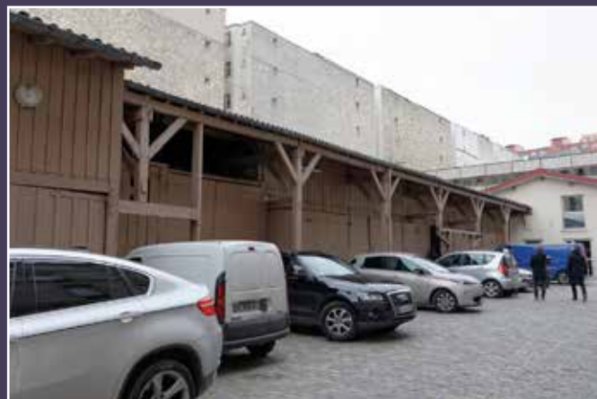
Hangars « à sept travées » (2014).
