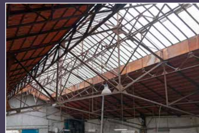
Vue actuelle de la charpente métallique.
