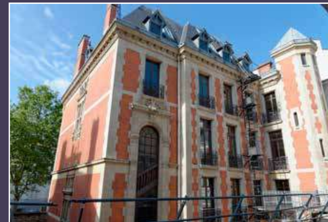
Vue actuelle de l'hôtel particulier depuis le bâtiment en fond de parcelle.
