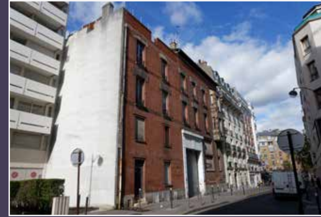
Vue actuelle du bâtiment donnant sur la rue Jean Dollfus.
