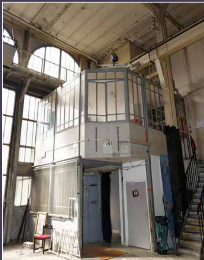
Vue du poste de contrôle dont la démolition est demandée.
