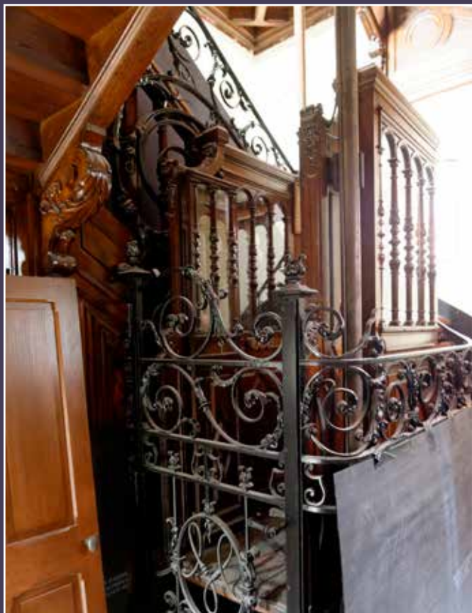
Vue actuelle de l'ascenseur de l'escalier principal avec détail de la ferronnerie.
