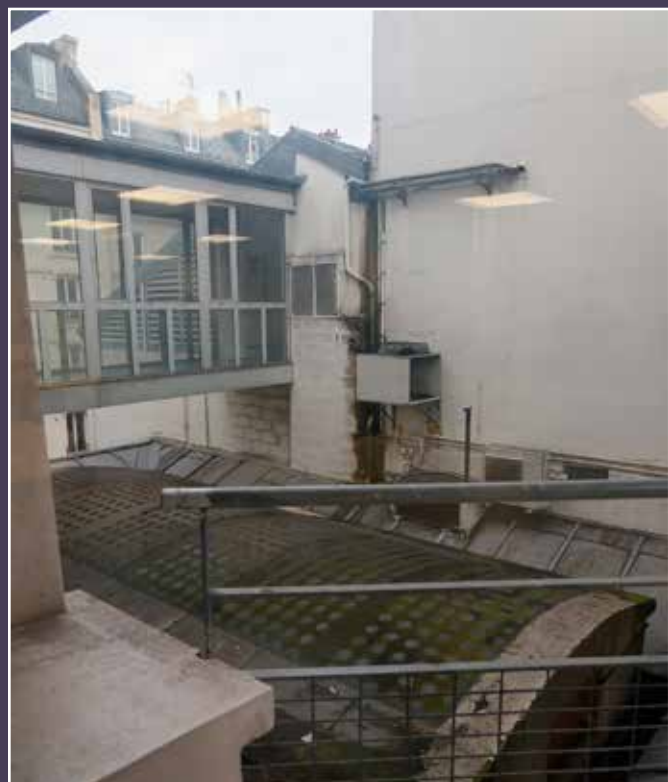
Vue actuelle de la passerelle.
