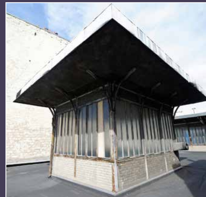
Vue d'un des deux lanterneaux en toiture.
