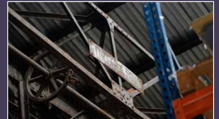
Vue actuelle d'un détail de la structure métallique.
