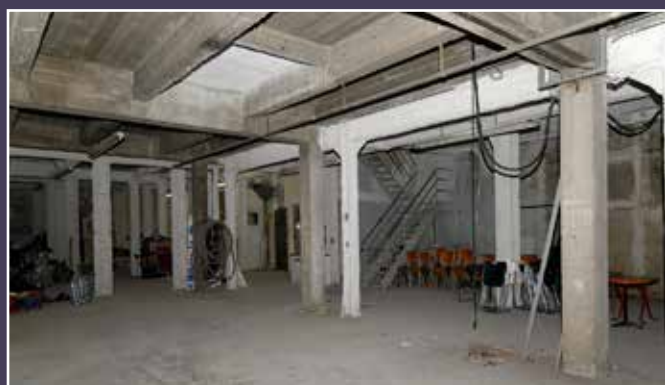
Vue du niveau de sous-sol avec sa structure et sa dalle béton.
