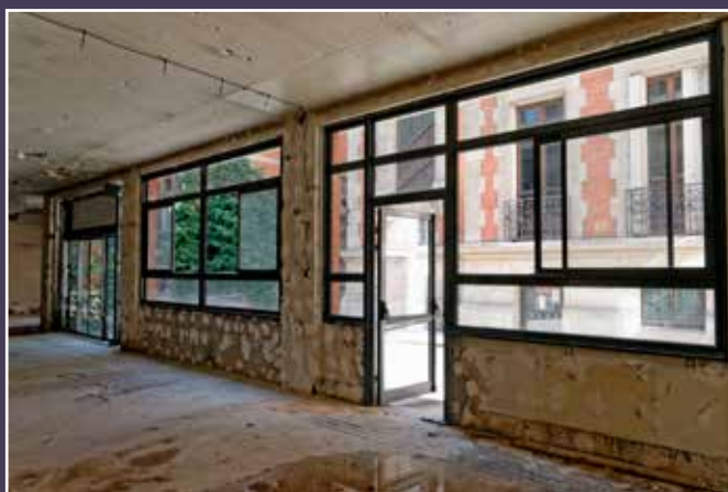
Vue actuelle du rez-de-chaussée du bâtiment en fond de parcelle.
