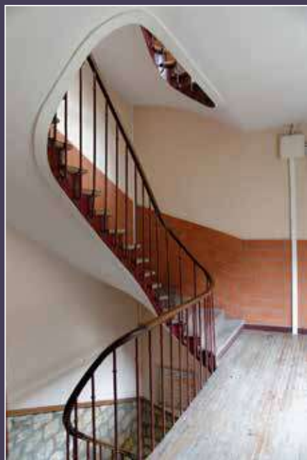
Escalier de la grande aile sur cour (2014).
