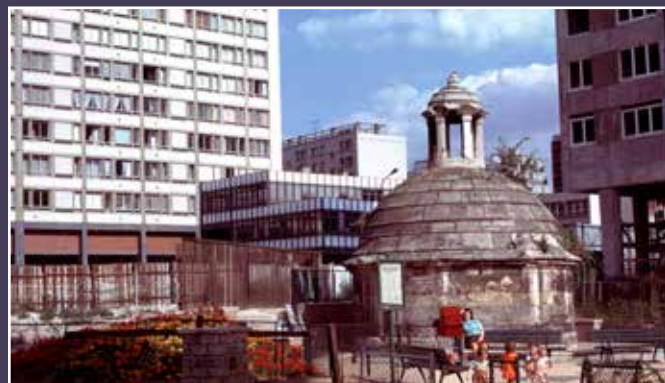
Vue de la lanterne et d'une des barres du peigne sud en 1975 (© Direction de l'Urbanisme / Ville de Paris).
