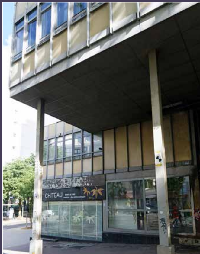
Vue de détail de la structure métallique et du porte-à-faux.
