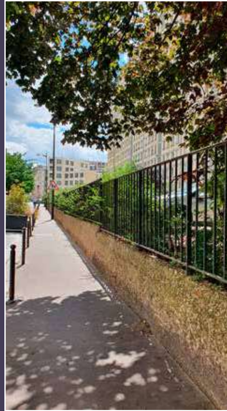
Vue de la rue des Meuniers. Au fond, l'opération en cours de construction.
