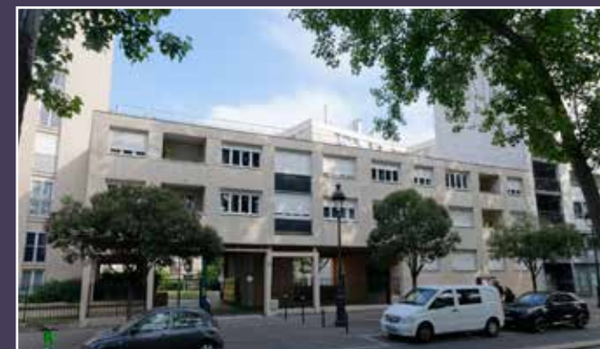
Vue du bâtiment formant porche du groupe le long du quai de la Seine.
