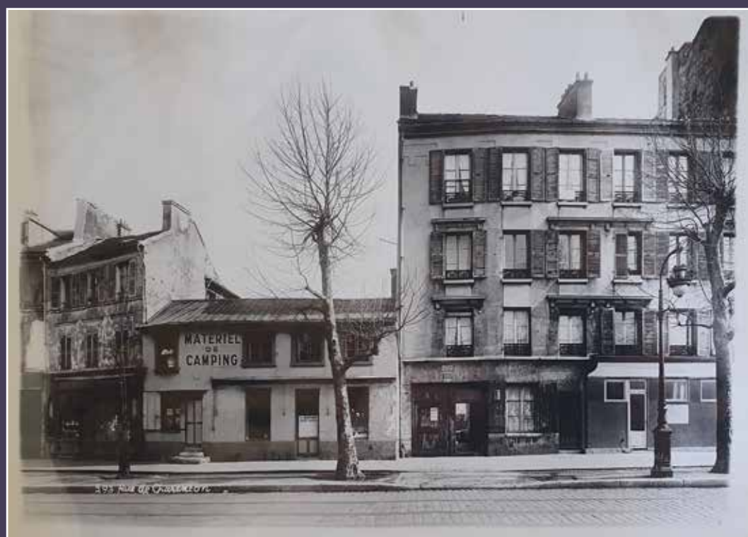
Vue de l'entrée du passage de la Grande Pinte aux 293-295, rue de Charenton, s.d. (vers 1960) (BHVP / OPHLM).
