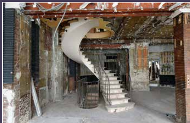
Escalier de la petite aile sur cour (2014).
