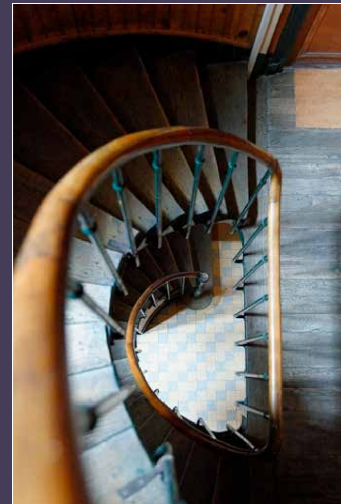
Vue de l'escalier du bâtiment sur cour.
