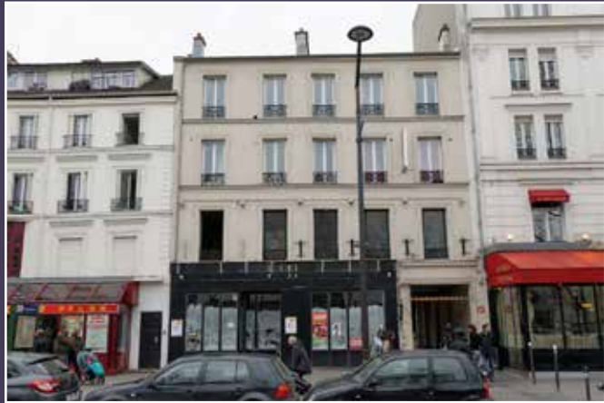
Immeuble sur rue (2014).
