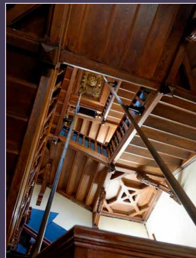
Vue actuelle de l'escalier principal en bois.
