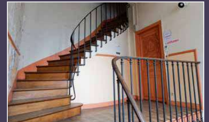
Vue actuelle de la cage d'escalier au R+2, avec l'ajout d'une rampe suite à la surélévation de l'immeuble.
