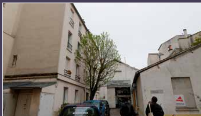
Vue du second immeuble, du garage et du bâtiment annexe.
