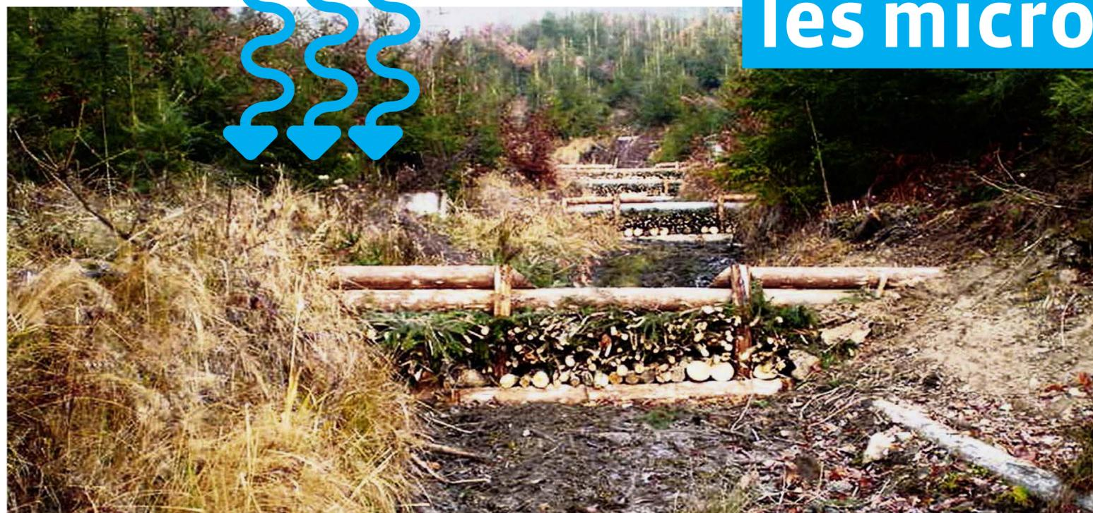
La construction de retenues et barrages permet de garder l'eau in situ et favorise l'apparition d'écosystèmes de sols humides. Avant, l'eau s'écoulait rapidement sous forme de torrent causant des inondations.
