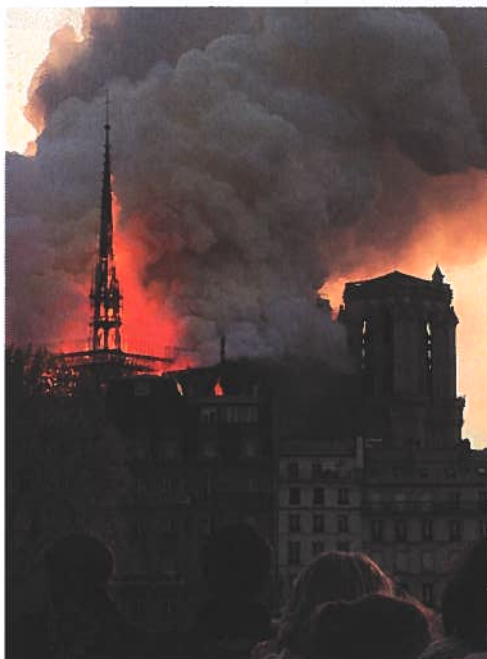
La flèche juste avant l'effondrement, 15/04/19 à 19h 24 - © Antoninnnnn CC BY-SA 4.0
