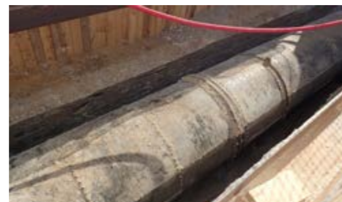
Conduite acier rivetée existante
