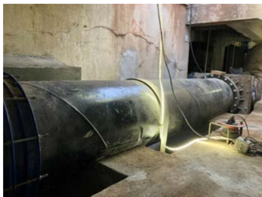
Conduite EP DN 600 posée en galerie
