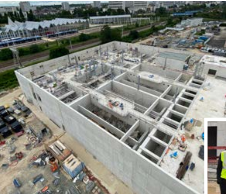
Vue de l'avancement du chantier en juillet 2021
