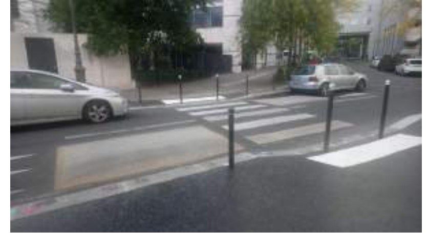
Aménagement d'une traversée piétonne rue Georges et Maï Politzer - 2019
