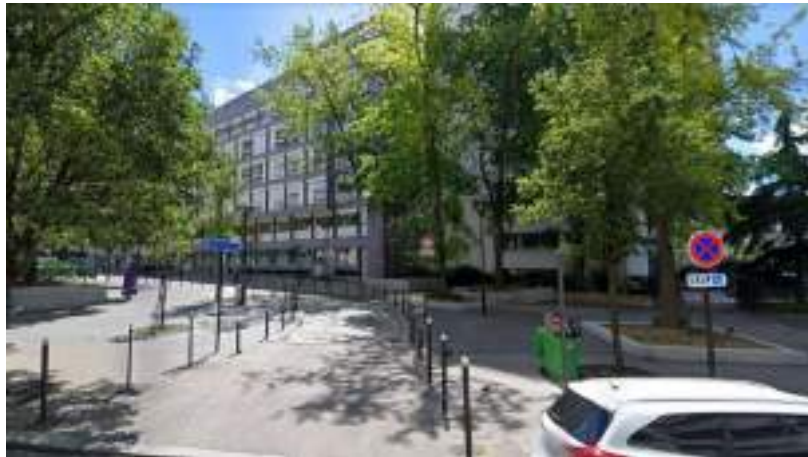
Réaménagement de la rue Eugénie Eboué - 2019
