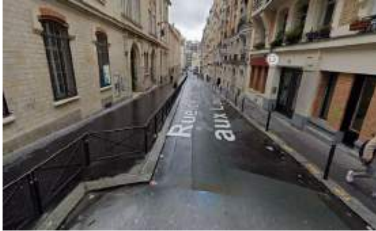
Élargissement du trottoir côté pair (côté école) rue de la Brèche aux Loups - 2018
