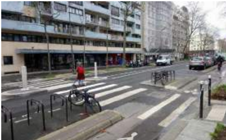
Aménagement d'une traversée piétonne au 90-92, av. Daumesnil - 2019
