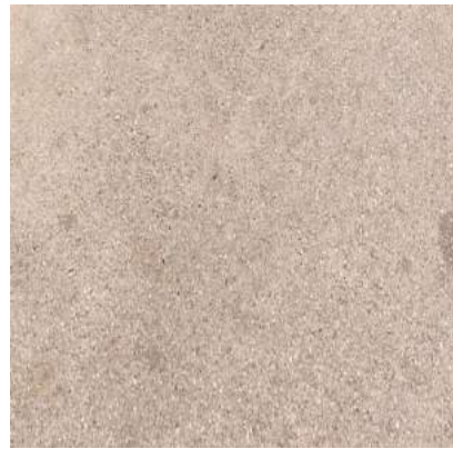
Promenade : allée en asphalte clair grenailé
