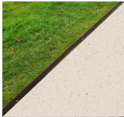
Limite entre plantation et sol minéral matérialisée par une volige métal
