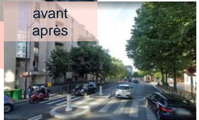
Sécurisation Carrefour Peugeot/Ibert
