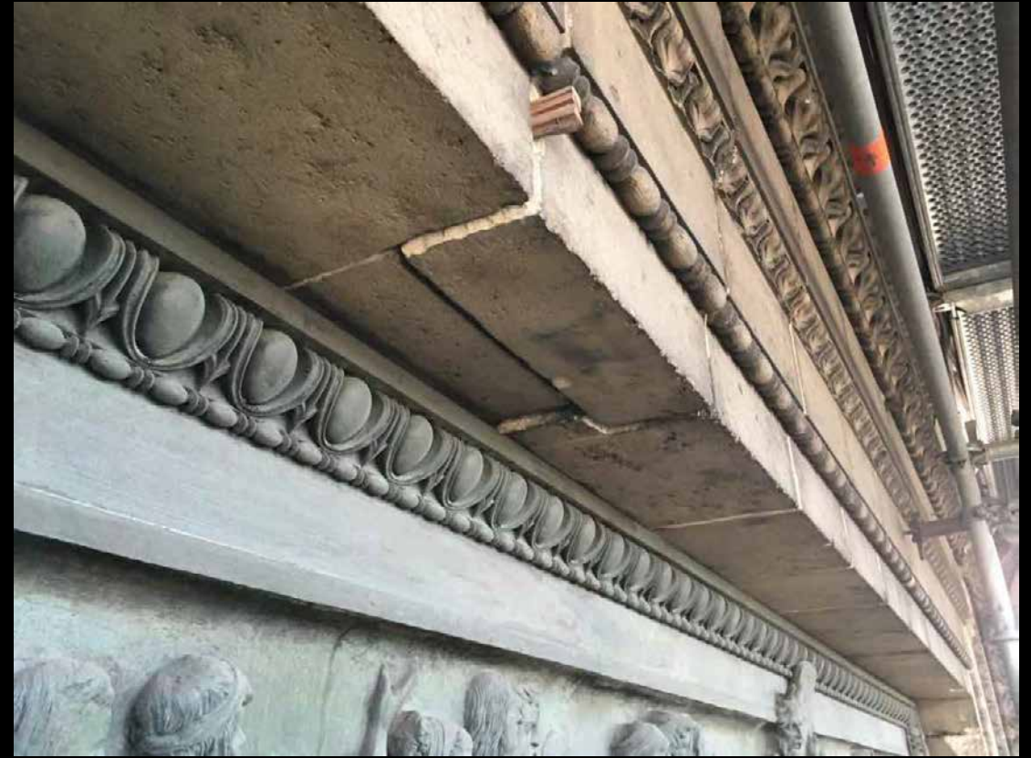
Fracture au-dessus de la porte d'entrée (2016)
