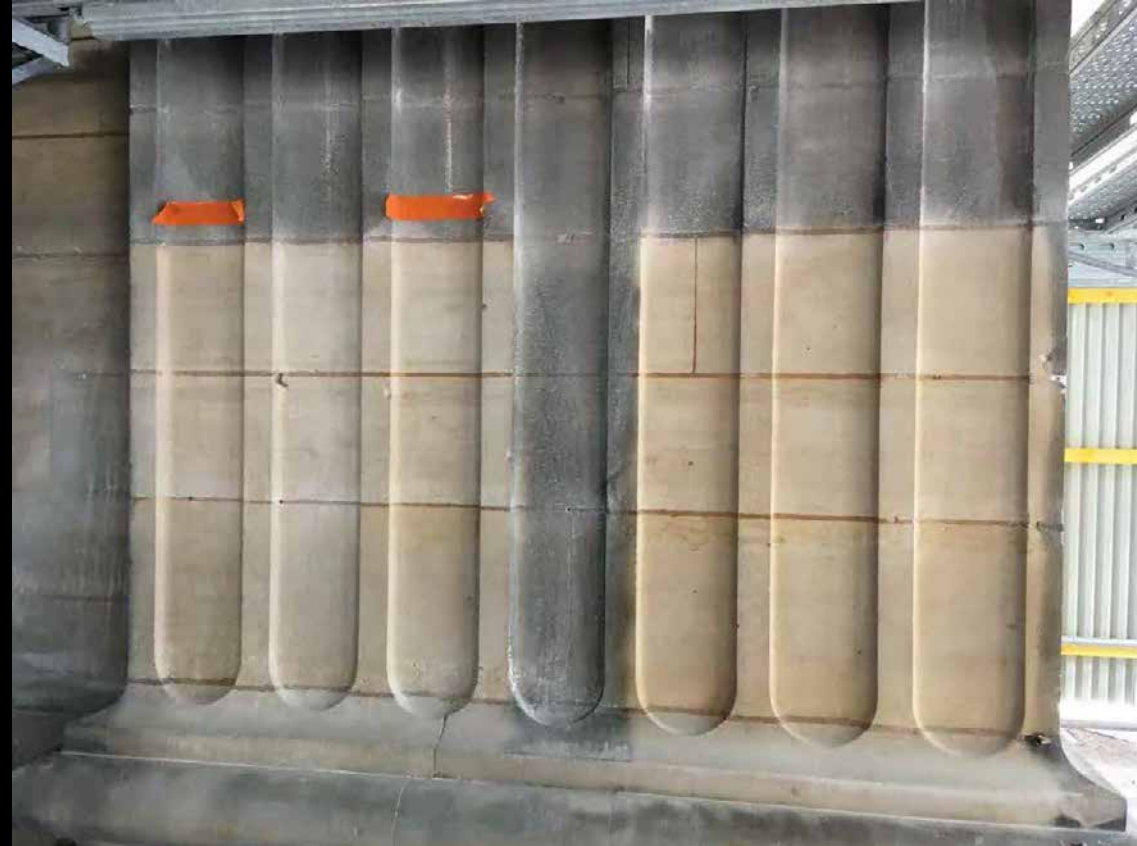
Essais de nettoyage (septembre 2021)
