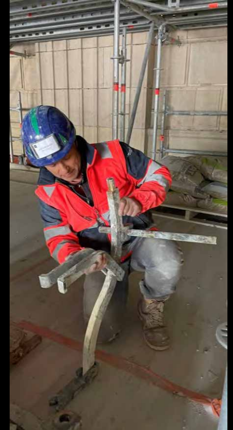
Dépose des parties réparées des chapiteaux et présentation des armatures (printemps-automne 2022)
