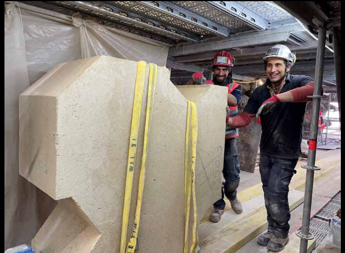
Acheminement des premiers bloc de pierre par l'ascenseur et sur transpalette (printemps 2022)
