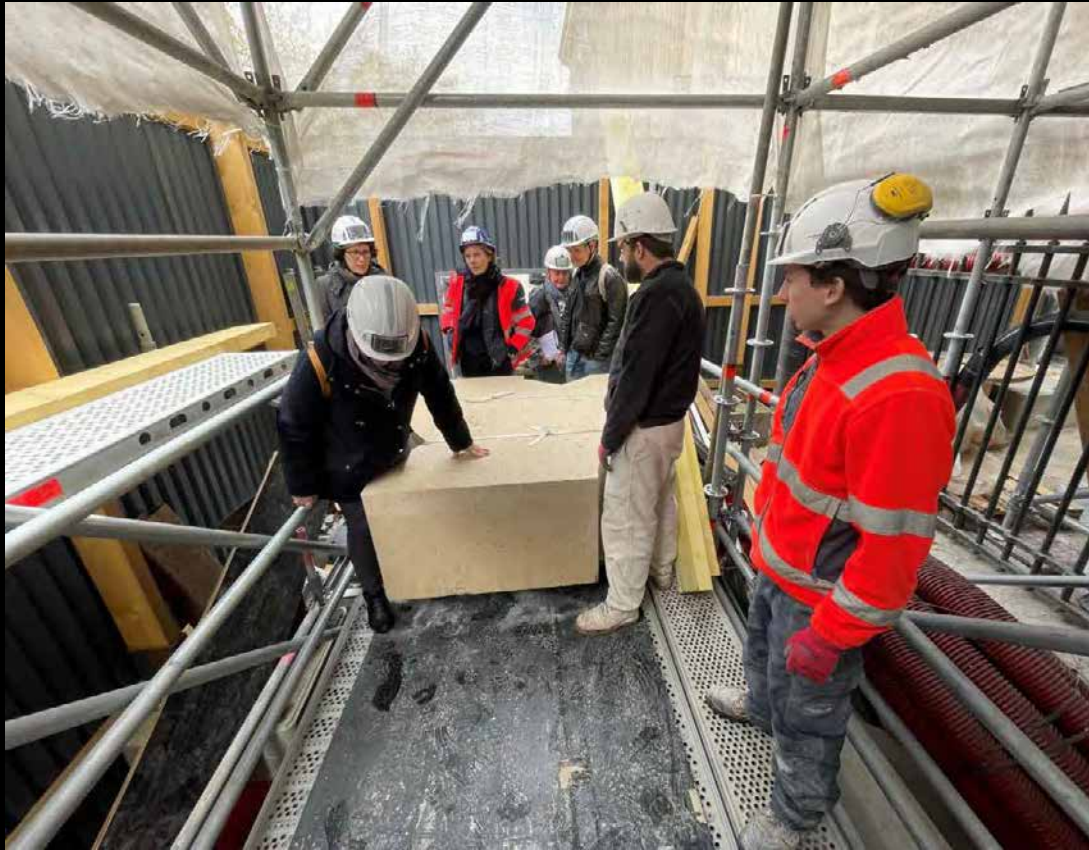
Acheminement des premiers bloc de pierre par l'ascenseur et sur transpalette (printemps 2022)
