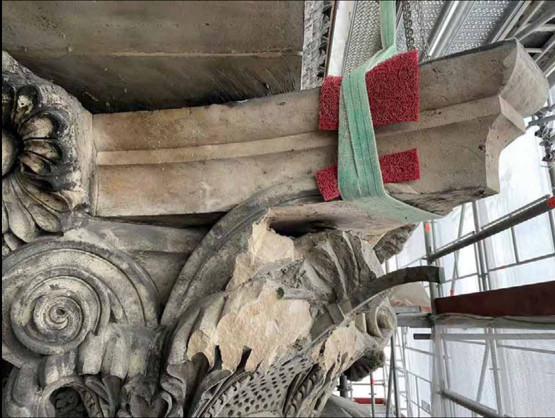
Dépose des parties réparées des chapiteaux et présentation des armatures (printemps-automne 2022)
