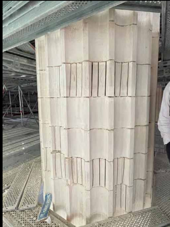
Remplacements de pierre des fûts de colonne (automne 2021 – automne 2022)
