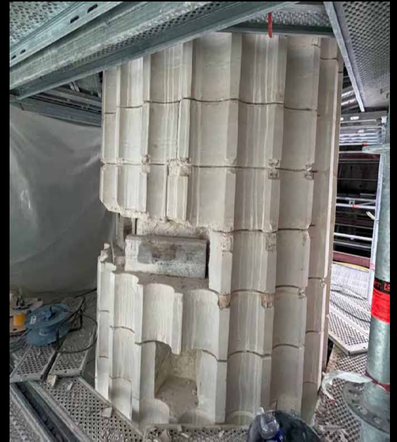
Remplacements de pierre des fûts de colonne (automne 2021 – automne 2022)
