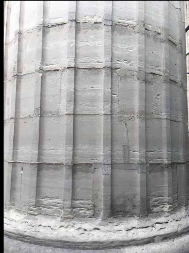
Localisation des pierres à remplacer sur les colonnes
