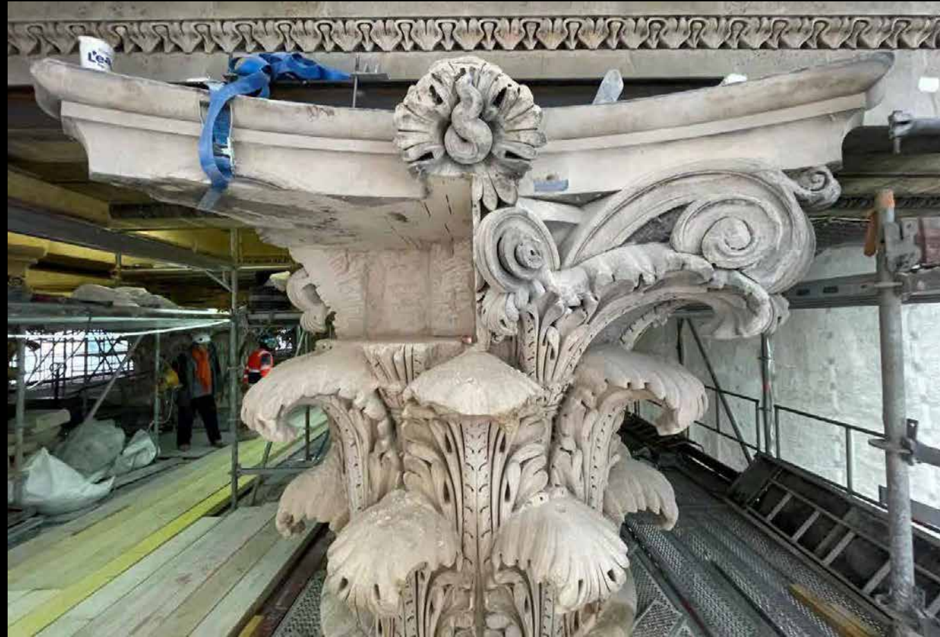
Chapiteau après dépose d'un premier bloc (printemps 2022)
