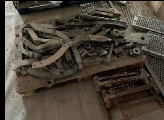
Dépose des parties réparées des chapiteaux et présentation des armatures (printemps-automne 2022)
