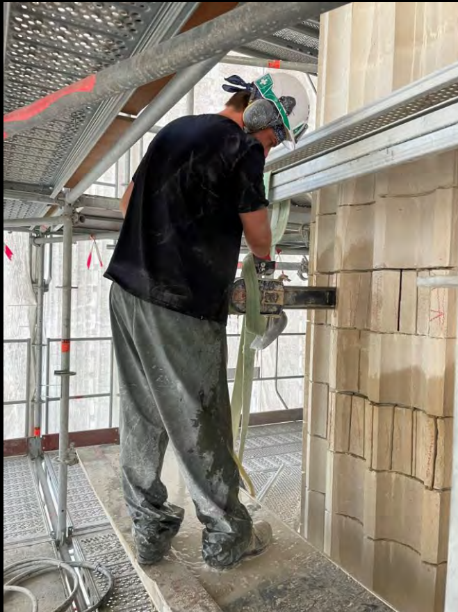
Remplacements de pierre des fûts de colonne (automne 2021 – automne 2022)
