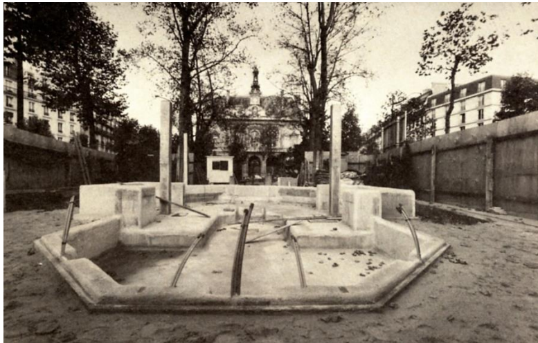
Travaux d'installation sur le parvis (1982)
