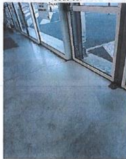
Dalle de sol - magasin provisoire
