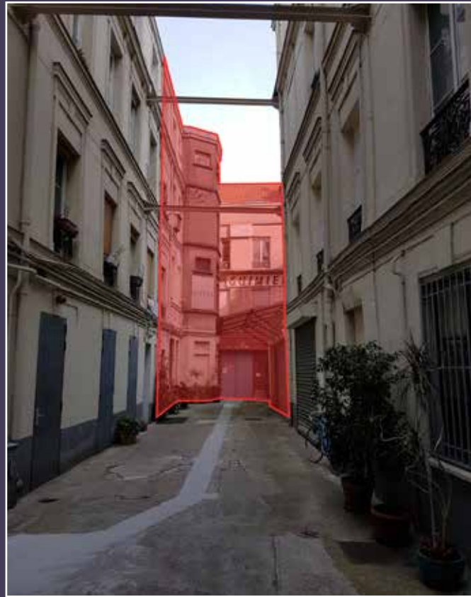
Photographie du fond cour avec indication des démolitions prévues en rouge (© HAME).
