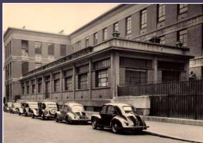
Vue des bâtiments rue Lhomond (Site du département de physique de l'ENS).
