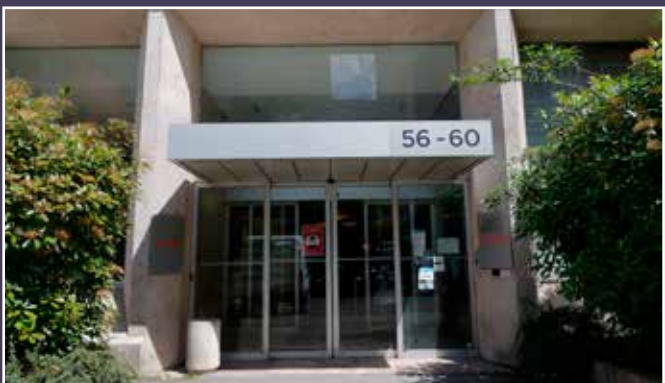
Vue actuelle de l'entrée du bâtiment.
