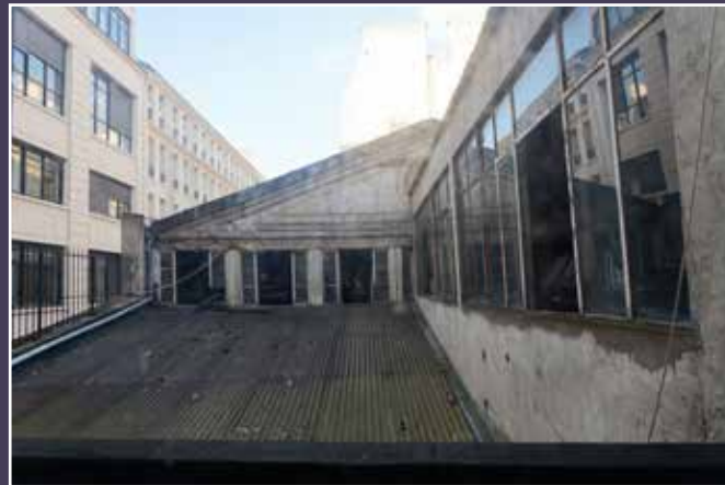
Vue du bâtiment industriel, du couvrement de la cour et de la « galerie » en béton ajoutée.
