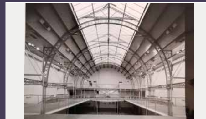
Photographie intérieure à la fin des travaux, 1986 (Documentation Reichen et Robert).
