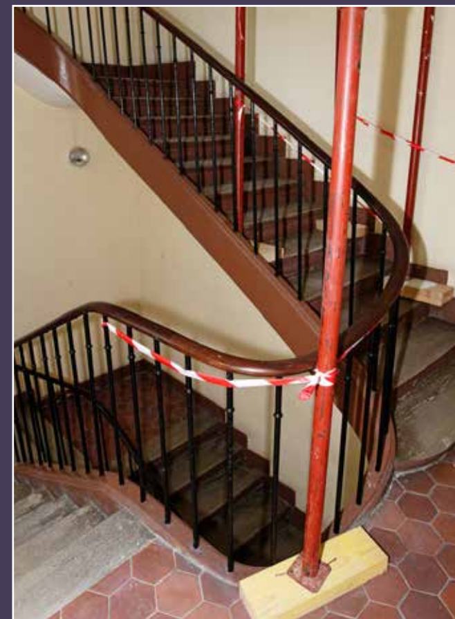
Vue actuelle de l'escalier principal dans l'aile droite.
