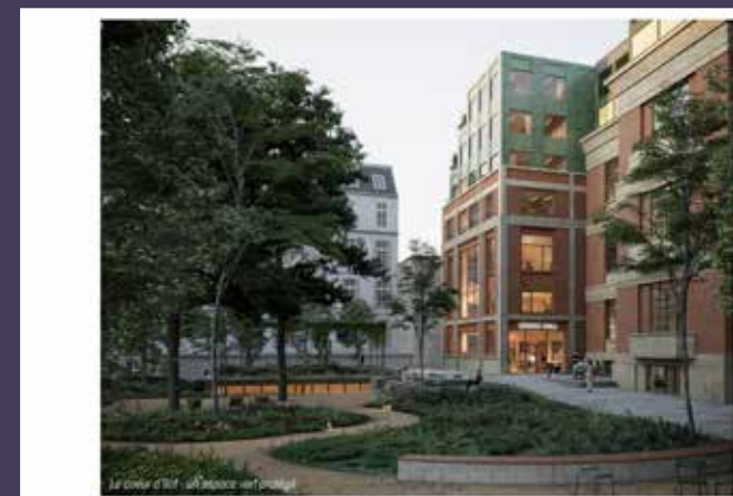
Vue d'insertion en coeur d'îlot (© Antonini architectes associés).
