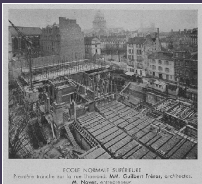
Photographie des travaux en cours sur le bâtiment rue Lhomond (publiée dans La Construction moderne , 1938).
