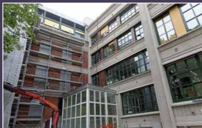
Travaux de rénovation et construction d'un sas en 2015.
