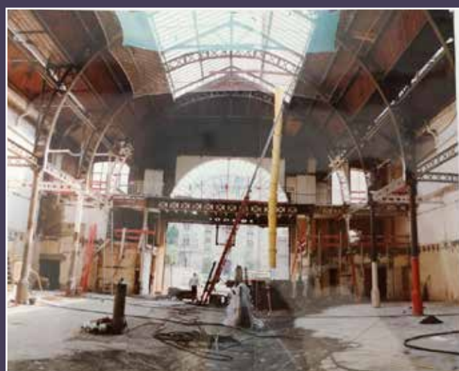
Photographie du chantier dans la grande halle, 1986 (Documentation Reichen et Robert).
