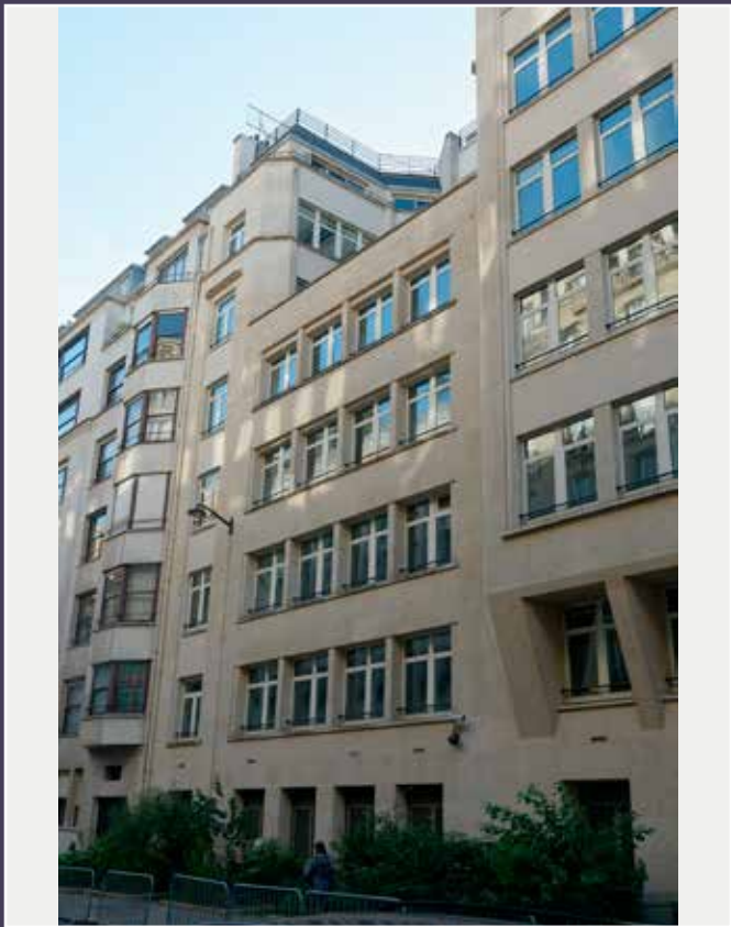
Vue rapprochée de la façade de l'extension.
