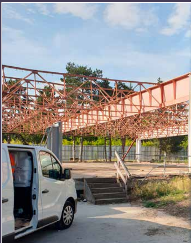
Vue actuelle du chantier de démolition.
