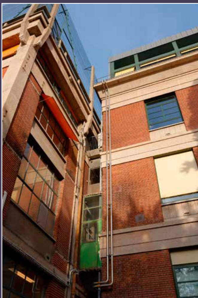
Jonction entre l'aile de physique et le Grand hall, côté jardin.
