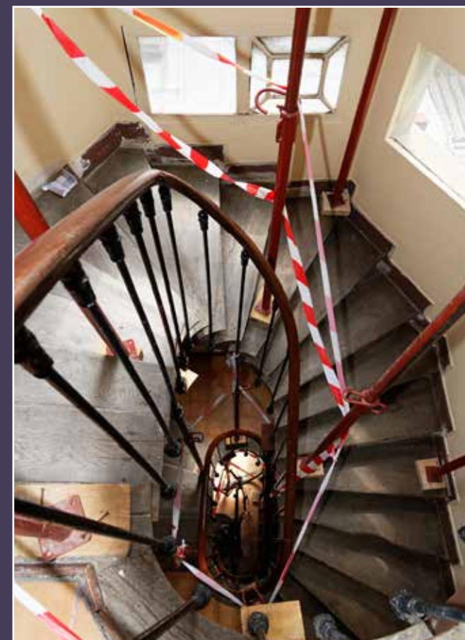
Vue actuelle de l'escalier dans la cage à pans coupés.
