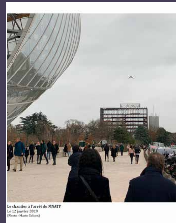
Vue du chantier en 2019 (© Marie Colson).
