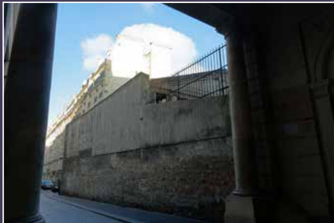
Surélévation du mur sur la rue Taylor dans le cadre de la construction du bâtiment industriel.
