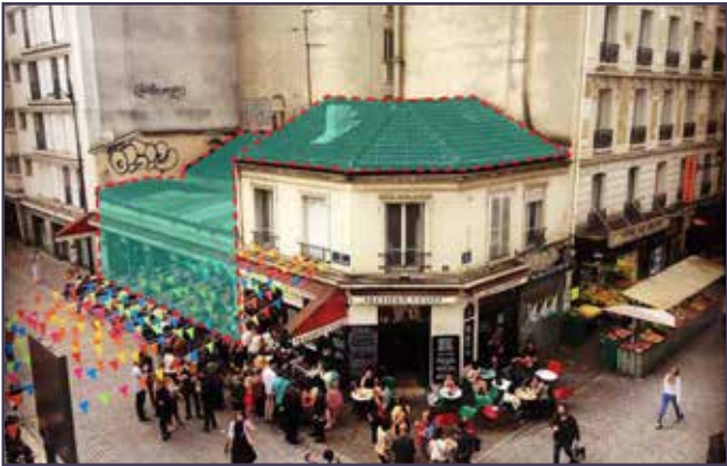
Vue des bâtiments à démolir (© Public Architecte).
