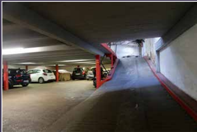
Vue du garage.
