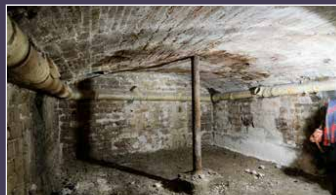
Vue de la voûte du premier sous-sol étayée.
