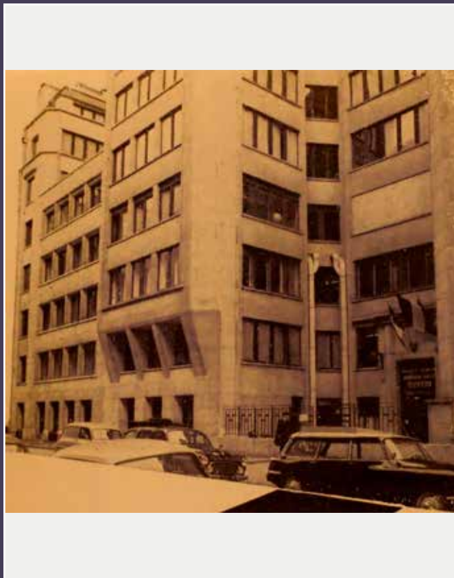
Vue extérieure de l'immeuble avec l'extension sur la cour de droite (publiée dans Le centre Alfred Lelluch , 1961, p.14).
