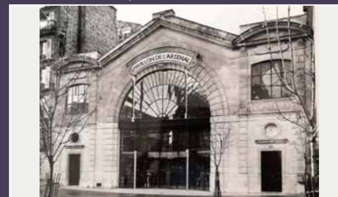
Photographie sur le boulevard à la fin des travaux, 1990 (Documentation Reichen et Robert).
