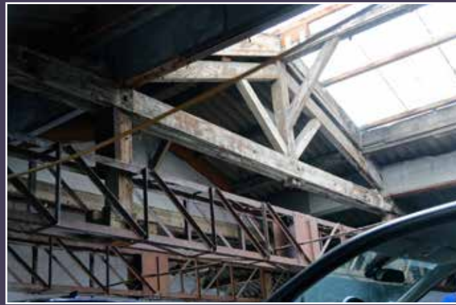
Renforcement structurel du bâtiment industriel lié à l'installation du garage.
