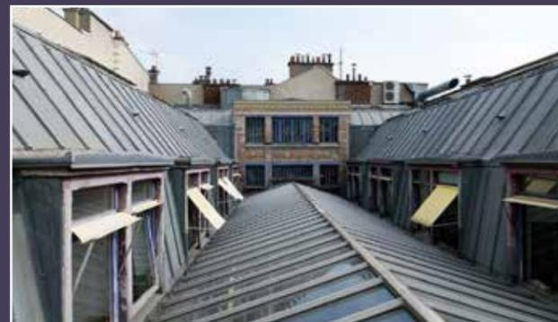
Vues de la verrière centrale de la seconde cour, des combles brisés des ailes construites entre 1886 et 1897 et des faibles pentes du bâtiment transversal.
