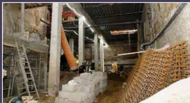
Vue actuelle du sous-sol suite à la démolition des caves, le creusement et la réalisation de la structure en béton armé en infrastructure.
