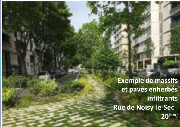
Exemple de massifs et pavés enherbés infiltrants
