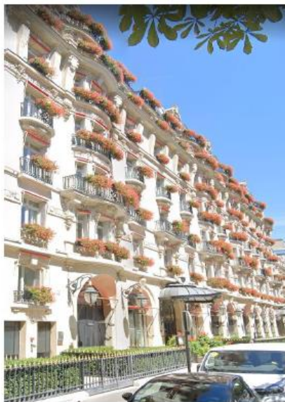
Photo du site vue depuis la rue après travaux inchangé
