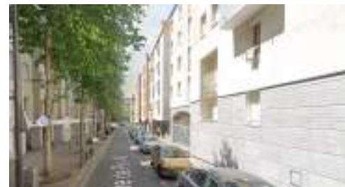
© Rue de Pali-Kao (construction 1975-2000)
