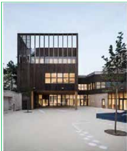
Isolation Thermique d'une toiture-terrasse en verre cellulaire
