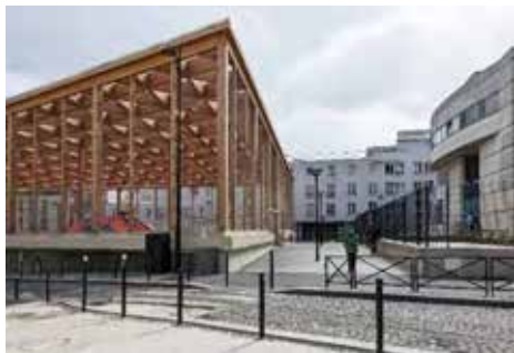
Gymnase Goutte d'or – 18 ème Maîtrise d'Ouvrage ParisSeine / DCPA
