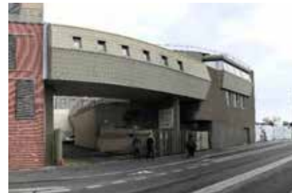
Adaptation de la cuisine scolaire 72 rue Riquet, 18 ème Étude de faisabilité en cours
