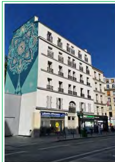
Isolation Thermique Extérieure en fibre de bois
