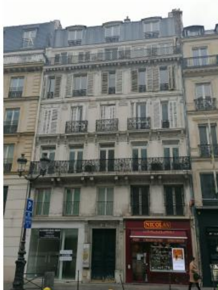
Photo du site vue depuis la rue après travaux Inchangé
