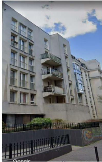
Photo du site vue depuis la rue après travaux
